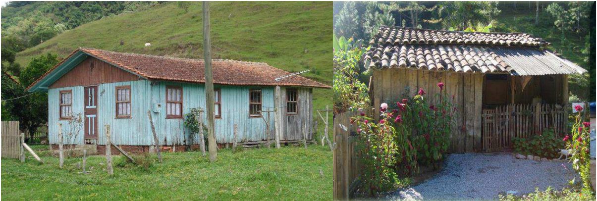
Figura 2. Residências de Madeira em Rancho Queimado e região.
