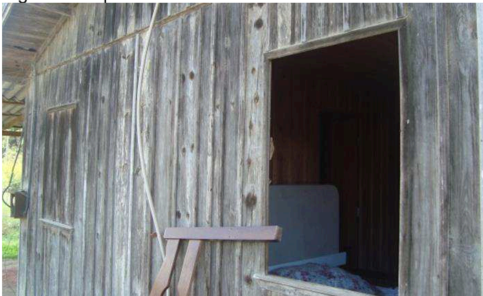
Figura 9. Esquadrias em madeira.
