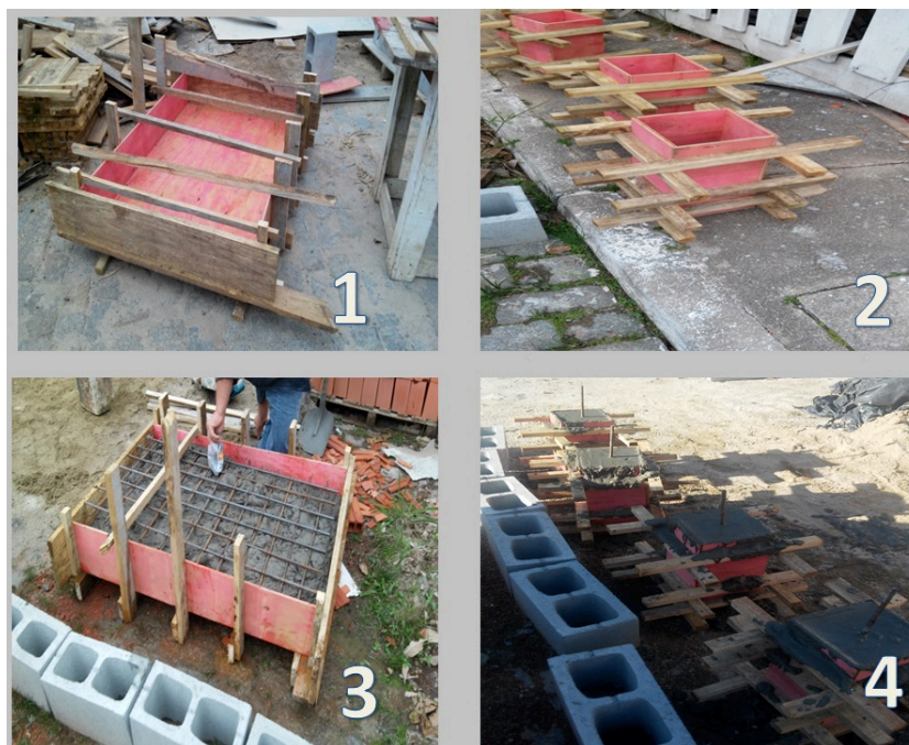
Figura 32: Procedimentos de execução da bancada de testes.
