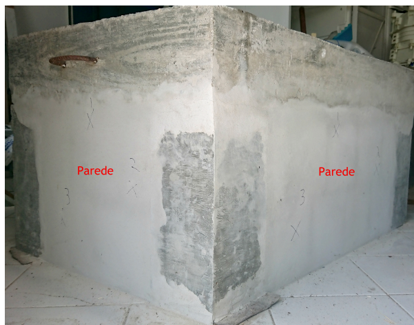
Figura 71: Paredes de alvenaria construídas abaixo da laje.
