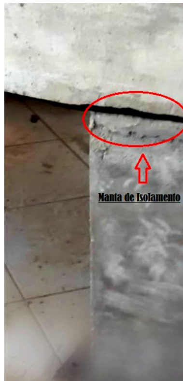
Figura 70: Manta de isolamento instalada acima dos pilares.
