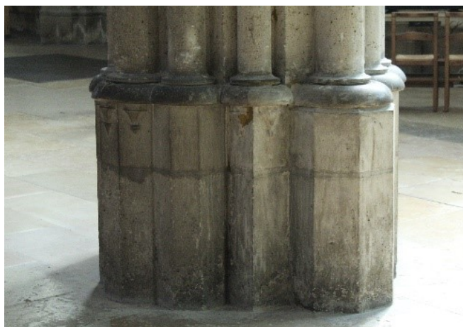
Base de pilar na Basílica Real de Saint Denis (França)
