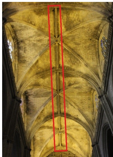
Nervura longitudinal na Catedral de Sevilha (Espanha)
