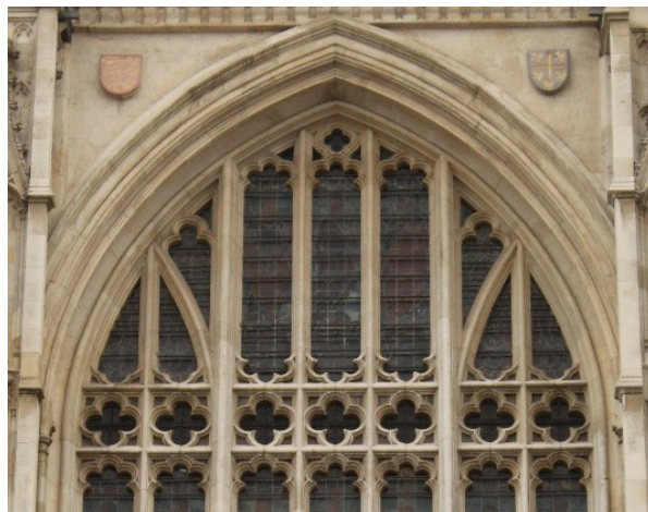
Traçado perpendicular na Abadia de Westminster (Reino Unido)
