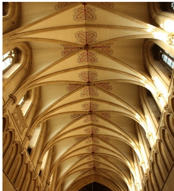
Abóbada da nave central da Catedral de Bristol (Reino Unido)
