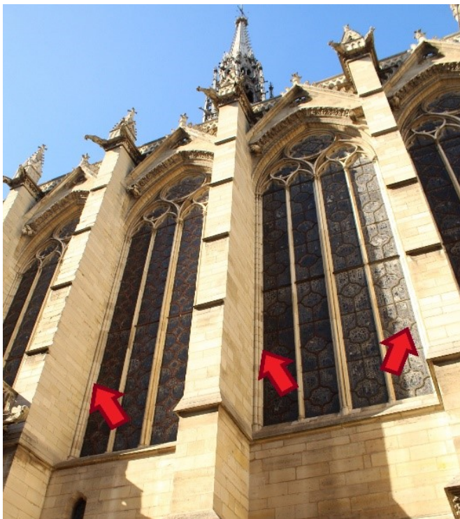
Contrafortes na Sainte Chapelle (França)
