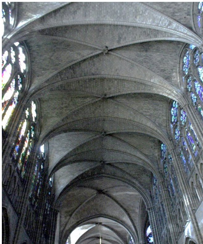
Abóbada de nervuras na Basílica Real de Saint Denis (França)
