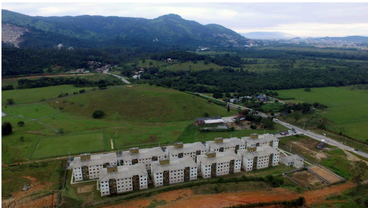
Imagem 2: Residencial Saudade, condomínio de baixa renda do PMCMV-FAR em Biguaçu, SC, construído em 2012.
