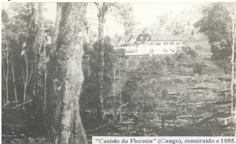
Figura 45 - Prédio “Castelo da Floresta” - 1955
