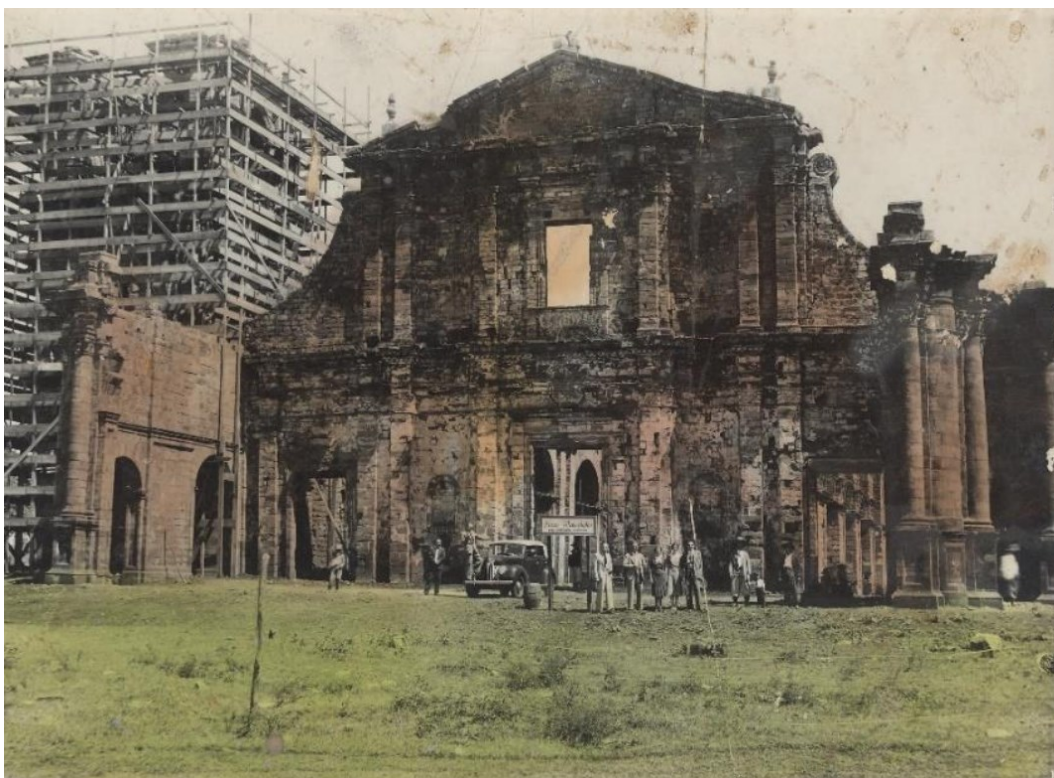
Figura 29: Obras de restauração das Ruínas de São Miguel
