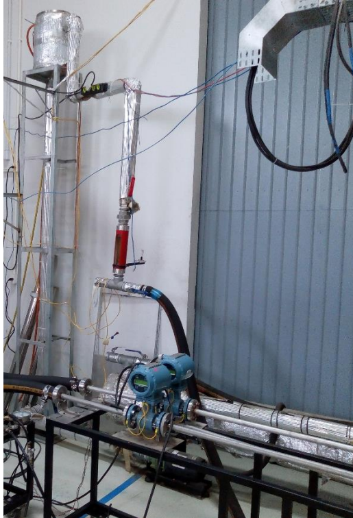
Figura 47– Fonte quente da bancada.
