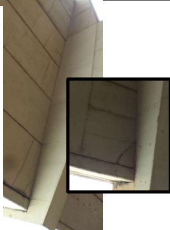
Fissura profunda aberta ( w > 0,3 ) na ponte em laje
