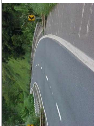
Falta de placa de ponte estreita e Degrau na pista (encontros)
