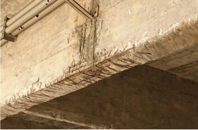
Figura 2-10 - Defeito na junta de dilatação
