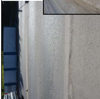
Fissura em linha no meio do vão da viga 8
