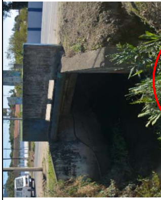
Manchas de umidade na laje 3
