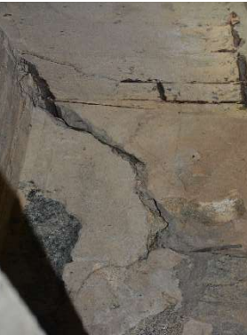
Fissura em linha a 45° nos cantos na travessa 1
