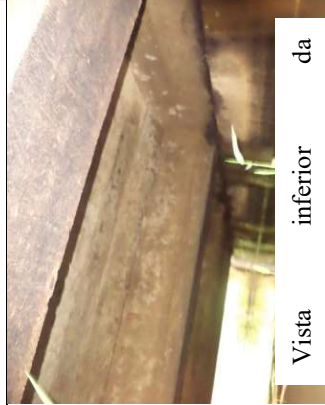
Lixiviação, mancha de carbonatação e infiltração no concreto
