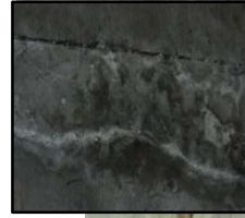
Fissura superficial: Lixiviação e mancha de carbonatação (Eflorescência)
