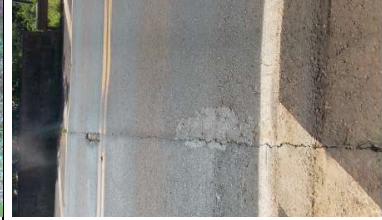
Vista da junta do encontro - Junta
