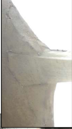
Rachadura ou trinca muito aberta - Proveniente de choque de embarcação
