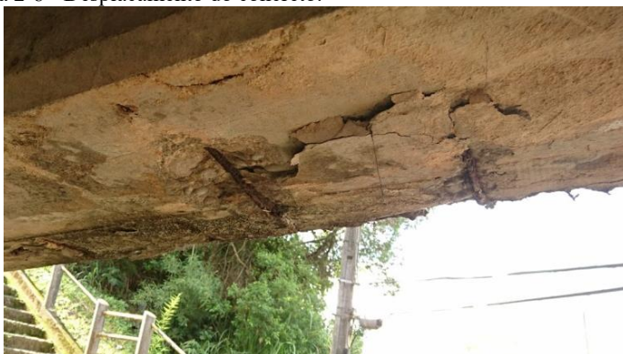
Figura 2-8 - Desplacamento do concreto.
