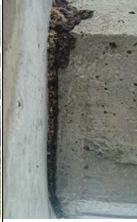
Aparelho de apoio – visualização obstruída por casulo de vespas
