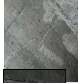
Fissura superficial: Lixiviação e mancha de carbonatação (Eflorescência)
