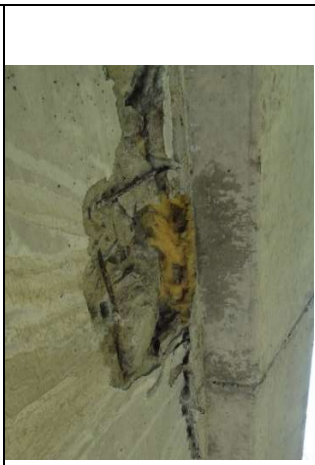
Deslocamento do concreto com armadura exposta
