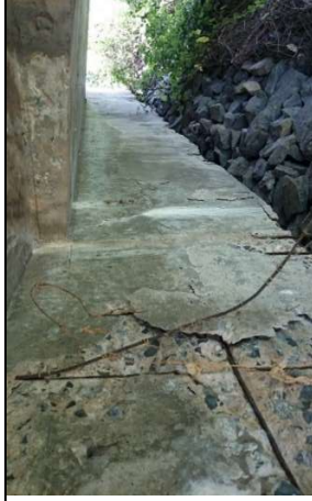
Encontro com cobrimento ineficiente do aço, armadura exposta e oxidada e deslocamento do concreto
