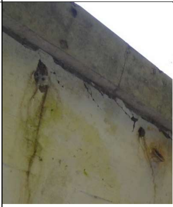
Deslocamento do concreto com armadura exposta
