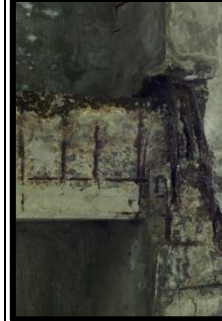
Dente Gerber de concreto armado - Região com concreto esmagado ou rompido, Infiltração no concreto, lixiviação e mancha de carbonatação, armadura exposta oxidada / Armadura sem cobrimento
