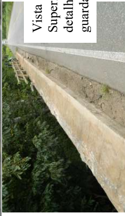
Fissura superficial: Lixiviação e mancha de carbonatação (Eflorescência)
