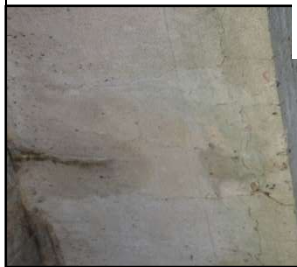
Fissura em linha no meio do vão da viga 8
