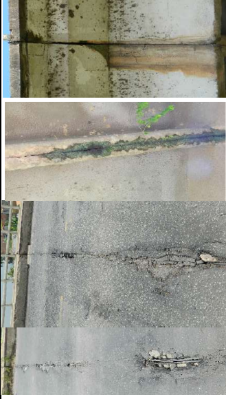
Rachadura ou trinca muito aberta - Proveniente de choque de embarcação
