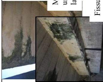
Manchas de umidade na laje 3
