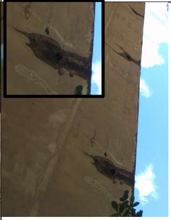
Infiltração no concreto (Dreno destruído) no balanço lateral direito
