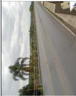
Guarda corpo obsoleto, sem acostamento
