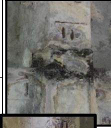
Dente Gerber de concreto armado - Região com concreto esmagado ou rompido, Infiltração no concreto, lixiviação e mancha de carbonatação, armadura exposta oxidada / Armadura sem cobrimento
