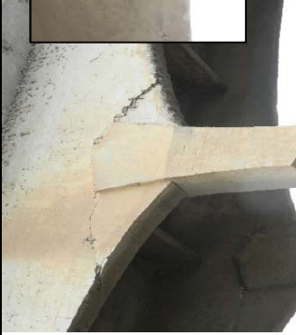
Rachadura ou trinca muito aberta - Proveniente de choque de embarcação
