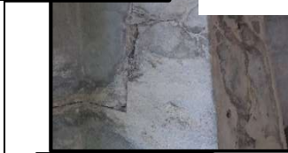
Dente Gerber de concreto armado - Região com concreto esmagado ou rompido, Infiltração no concreto, lixiviação e mancha de carbonatação, armadura exposta oxidada / Armadura sem cobrimento
