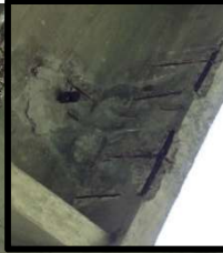
Viga T ou I - Ferragem principal muito oxidada em pontos localizados / Armadura sem cobrimento, concreto desagregado com armadura exposta e oxidada / Infiltração no concreto
