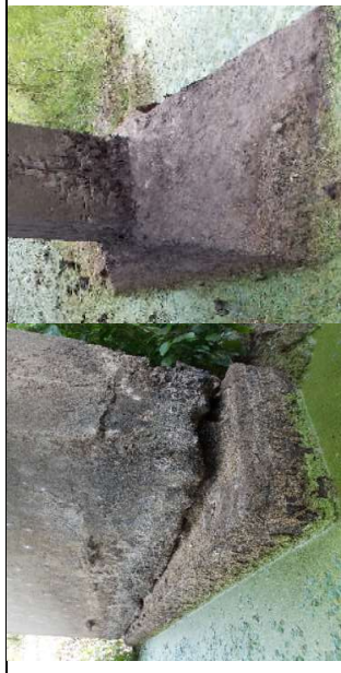
Bloco ou sapata de concreto armado - Fissura profunda aberta ( w > 0,3 mm), deslocamento de concreto com armadura exposta (nicho de concretagem)
