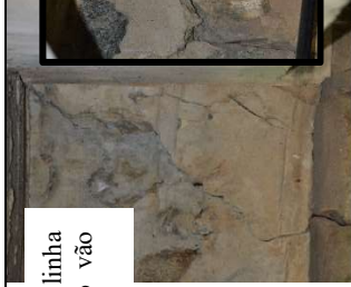
Manchas de umidade na laje 3
