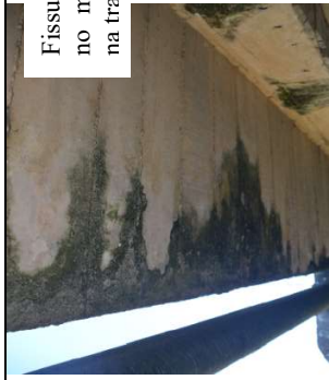
Manchas de umidade na laje 3
