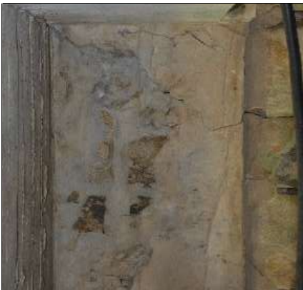
Corrosão da armadura com deslocamento na viga 3
