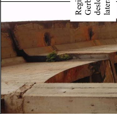
Guarda corpo obsoleto, sem acostamento
