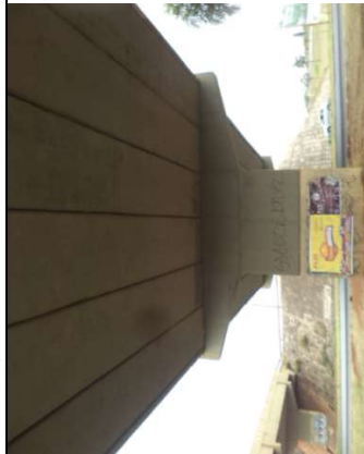
Lixiviação e mancha de carbonatação
