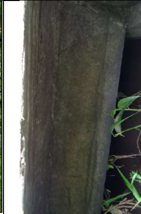
Lixiviação, mancha de carbonatação e infiltração no concreto
