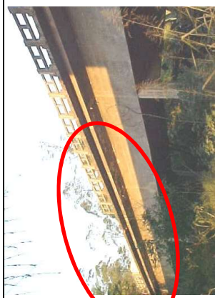
Guarda-corpos danificados e destruídos
