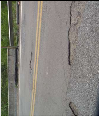
Pavimento danificado na entrada da ponte
