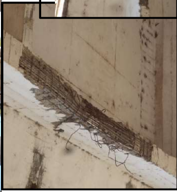
Deslocamento de concreto com armadura exposta na viga
