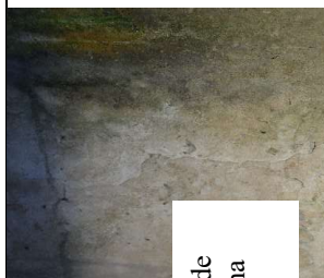
Manchas de umidade na laje 3
