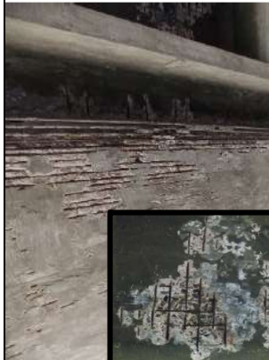
Viga T ou I - Ferragem principal muito oxidada em pontos localizados / Armadura sem cobrimento, concreto desagregado com armadura exposta e oxidada / Infiltração no concreto
