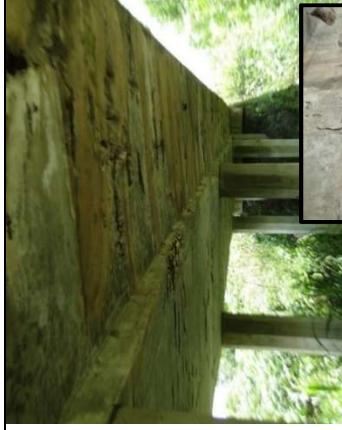
Encontro com cobrimento ineficiente do aço, armadura exposta e oxidada e deslocamento do concreto
