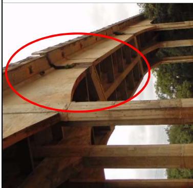
Guarda corpo obsoleto, sem acostamento
