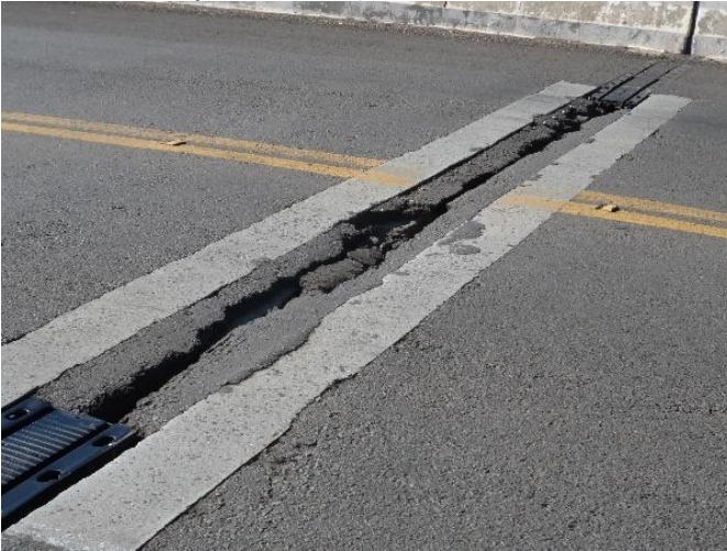
Figura 2-10 - Defeito na junta de dilatação
