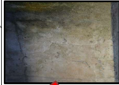
Manchas de umidade na laje 3
