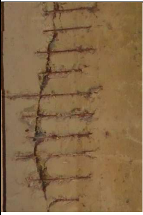
Fissura com armadura exposta e corroída
