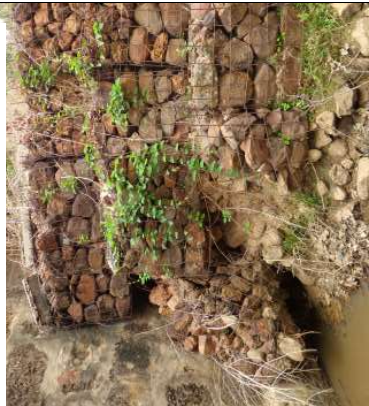
Erosão do talude de aterro - Encontro 1 - Lado esquerdo
