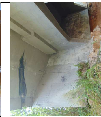
Infiltração no concreto (Dreno destruído) no balanço lateral direito
