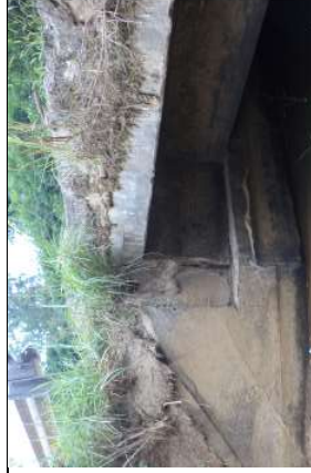
Cortina de concreto armado com Lixiviação, mancha de carbonatação e infiltração
