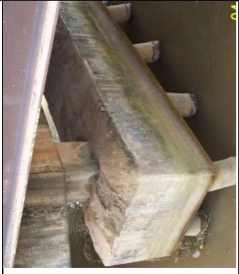
Fissuras e infiltração na laje
