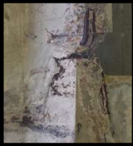
Viga T ou I - Ferragem principal muito oxidada em pontos localizados / Armadura sem cobrimento, concreto desagregado com armadura exposta e oxidada / Infiltração no concreto
