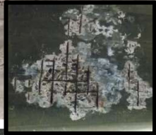
Ferragem principal muito oxidada em pontos localizados / Armadura sem cobrimento
