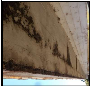
Infiltração no concreto na laje
