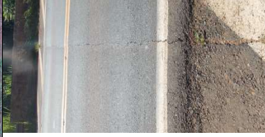
Vista da junta do encontro - Junta
