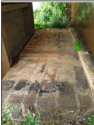
Erosão do talude de aterro - Encontro 1 - Lado esquerdo
