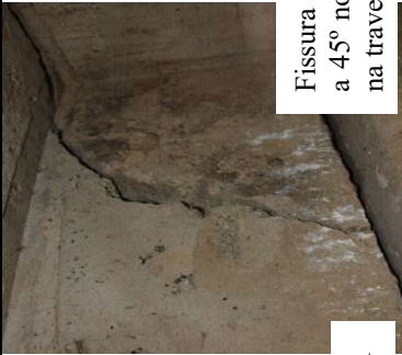
Fissura em linha a 45° nos cantos na travessa 1
