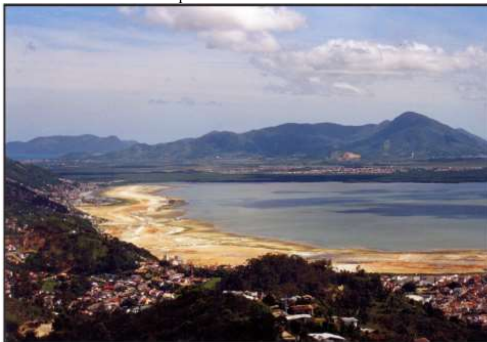
Foto 1: O aterro da Via Expressa Sul sobre a enseada do Saco dos Limões.
