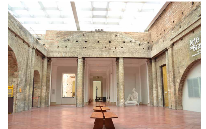
fig. 6 - Marcas do antigo telhado na sala de exposição
