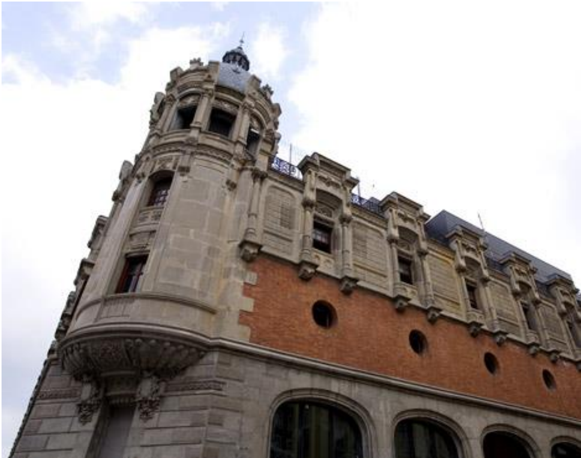
Figura 5 – Fachada com intervenção
