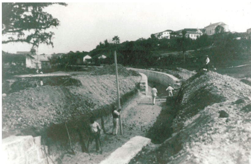
Canalização do Rio da Bulha em 1919.
