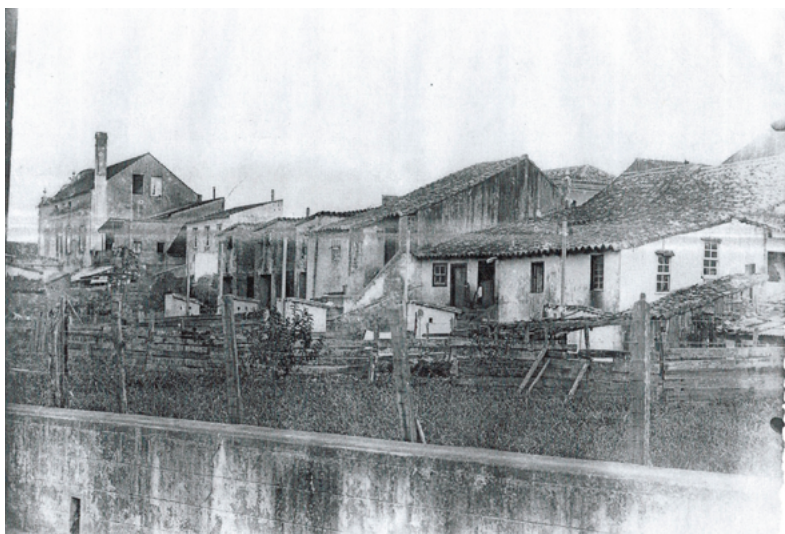
Entorno do Rio da Bulha em 1920, já durante as obras de canalização.
