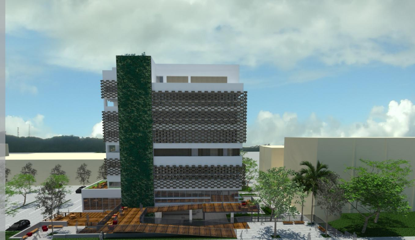
A fachada principal, voltada para o sul, recebeu uma parede jardim que começa no pavimento térreo e segue até a cobertura. Esse elemento salienta a verticalidade da edificação ao mesmo tempo em que contrapõe as linhas horizontais criada pelos brises e pelas janelas em fita.
