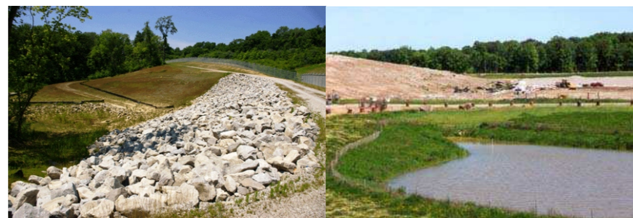
Figura 124: Bacia de retenção do tipo seca Fonte: Estudo de Bacias de Retenção
