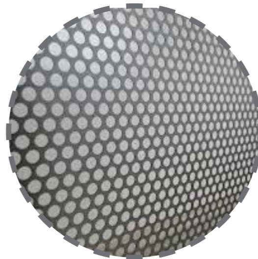
Fachadas: Chapa metálica perfurada, para garantir ventilação constante e insolação moderada
