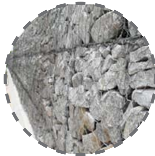
Muros de arrimo: Gabiões feitos com resíduos de concreto da construção civil
