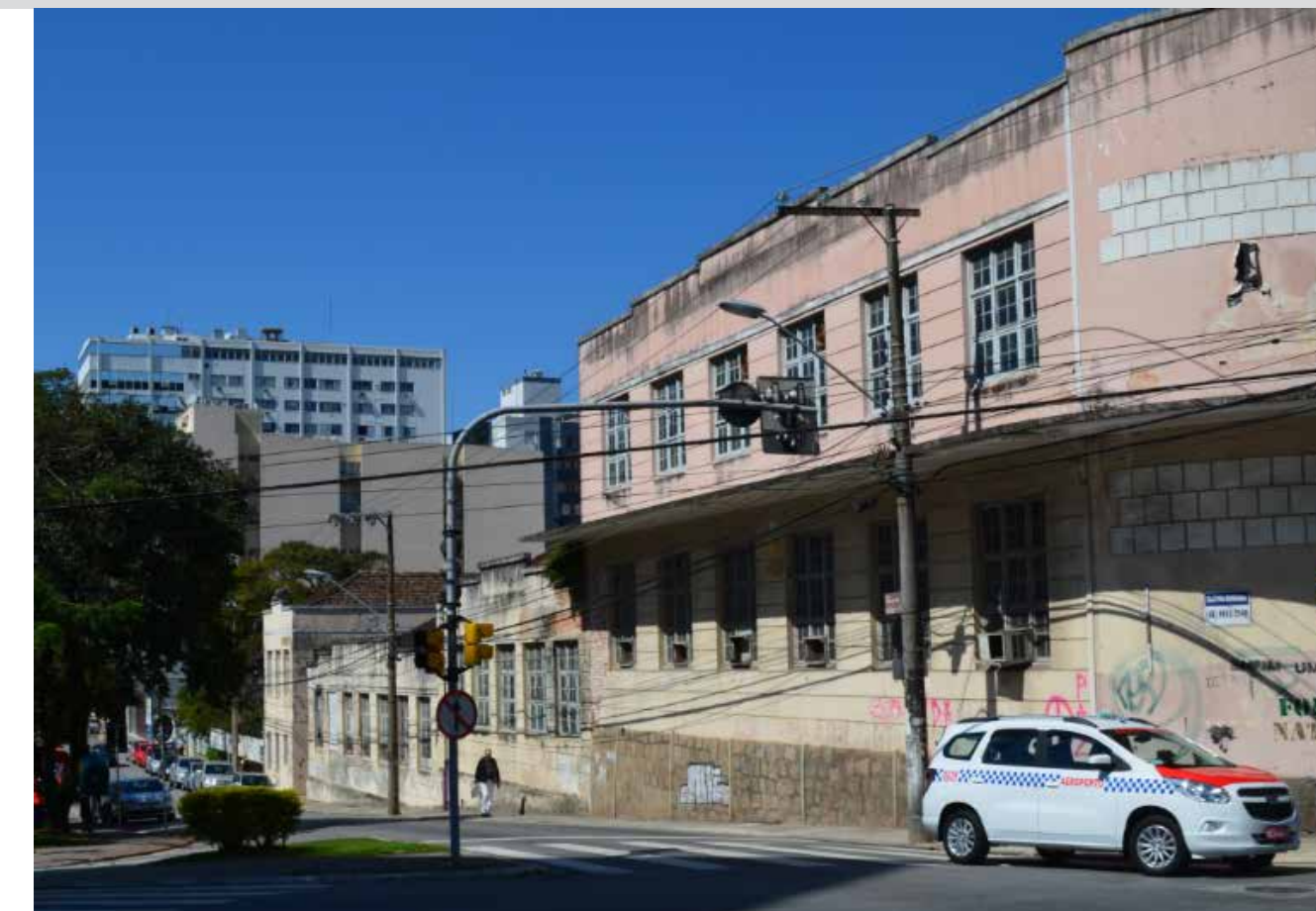
Figura 59: Foto pessoal do alto da Rua Felipe Schmidt. Infraestrutura de iluminação pública aérea em conflito com as edificações históricas. No poste da esquina ocorre um corte na marquise do edifício para locação deste. Proposta: Infraestrutura subterrânea e iluminação pública no lado oposto do Conjuntos Histórico.
