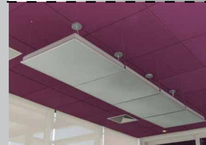
PANO ACÚSTICO: IMAGEM ILUSTRANDO A APLICAÇÃO DO PANO ACÚSTICO SOB FORRO MINERAL.
