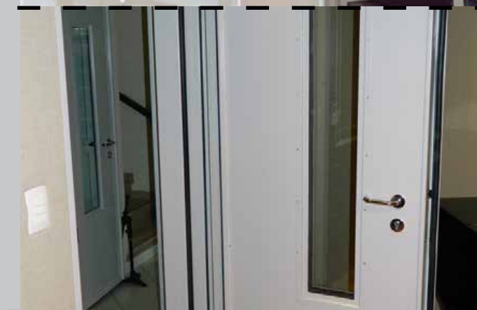
PORTA DE VEDAÇÃO ACÚSTICA: SERÁ TAMBÉM UTILIZADA NA SALA DE CONCERTOS, COM BARRA ANTI-PÂNICO.
