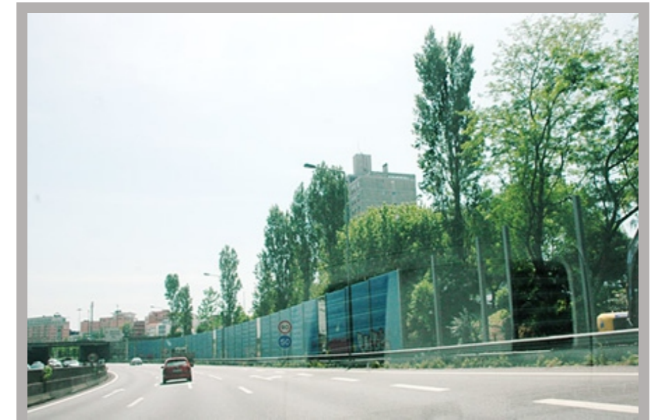
BARREIRA ACÚSTICA + VEGETAÇÃO FONTE: WWW.AECWEB.COM.BR
