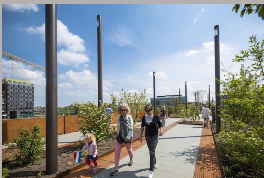
PONTE PALÁCIO - PASSARELA PARA PEDESTRES E CICLISTAS HERTOGENBOSCH - HOLANDA FONTE: WWW.HYPENESS.COM.BR
