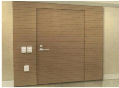
Imagem 10: Exemplo de piso e parede diferenciados e altura especial para os interruptores e tomadas.
