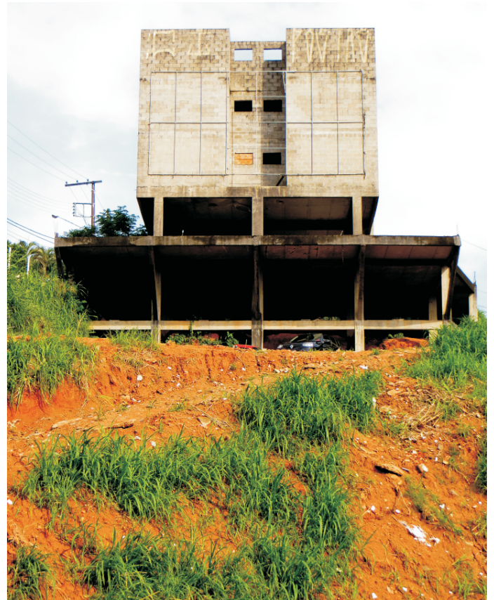
Prédio abandonado na fase de construção. Fonte: autor.
