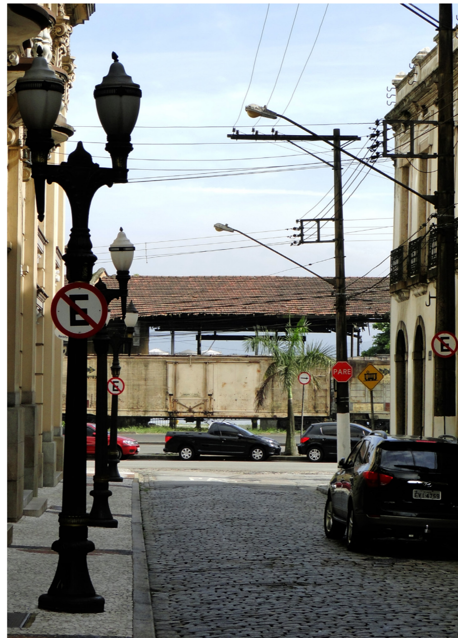
[ imagem 41 ] Armazéns abandonados. Ao fundo, edifício da Bolsa do Café.
