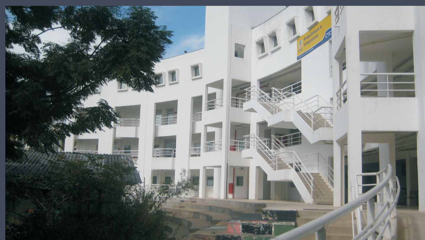
ArqUFSC 2012, prédio construído; Foto: acervo pessoal.
