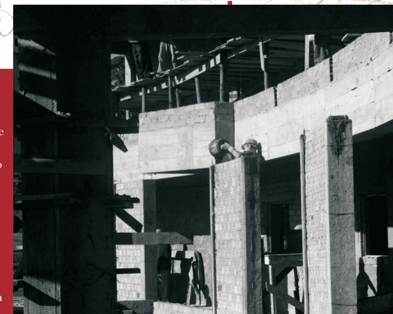
Fotos dos panos de alvenaria sendo construídos depois da estrutura acabada. Crédito das fotos: Marcelo Cabral Vaz
