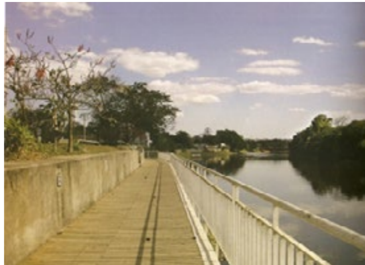
Substituição de estruturas nas margens do rio. Fonte: Rios e Cidades, Ruptura e Reconciliação. GORSKI, Maria Cecília Barbieri. Págs. 200-201.
