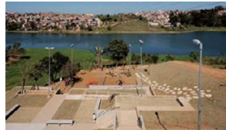
Equipamentos do Parque. Fonte: arcoweb.com.br
