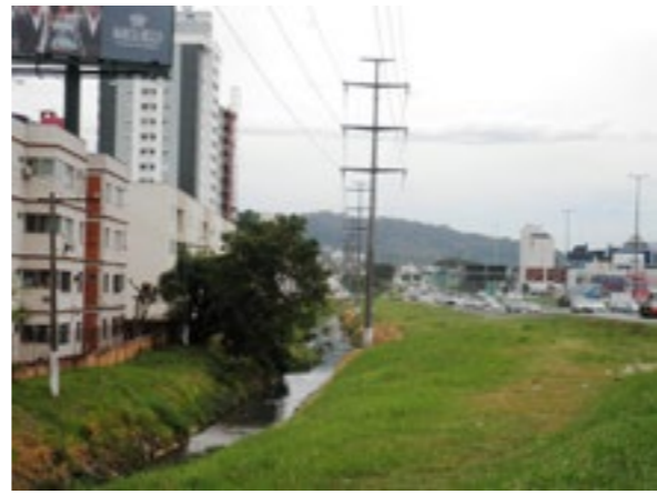
Trecho do rio paralelo à Via Expressa. Acervo pessoal.
