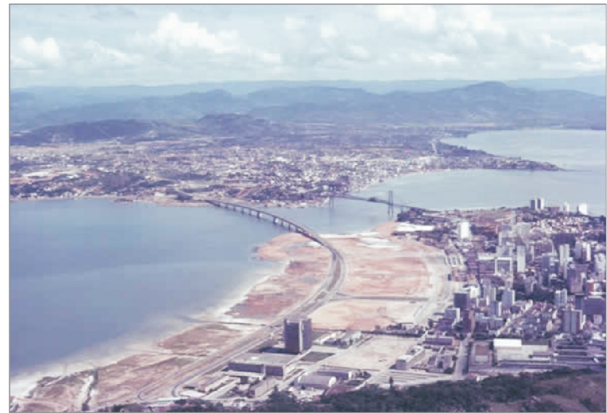
Vista da Baía Sul com aterro - Década de 1970
