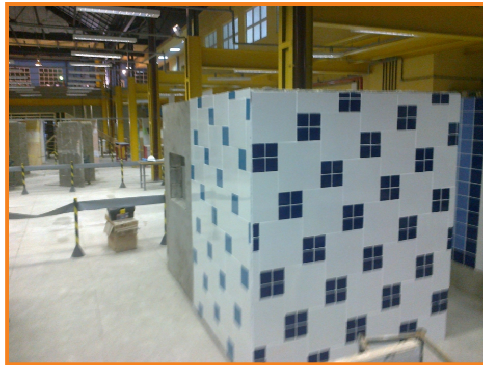
Aplicação de Revestimento Cerâmico
