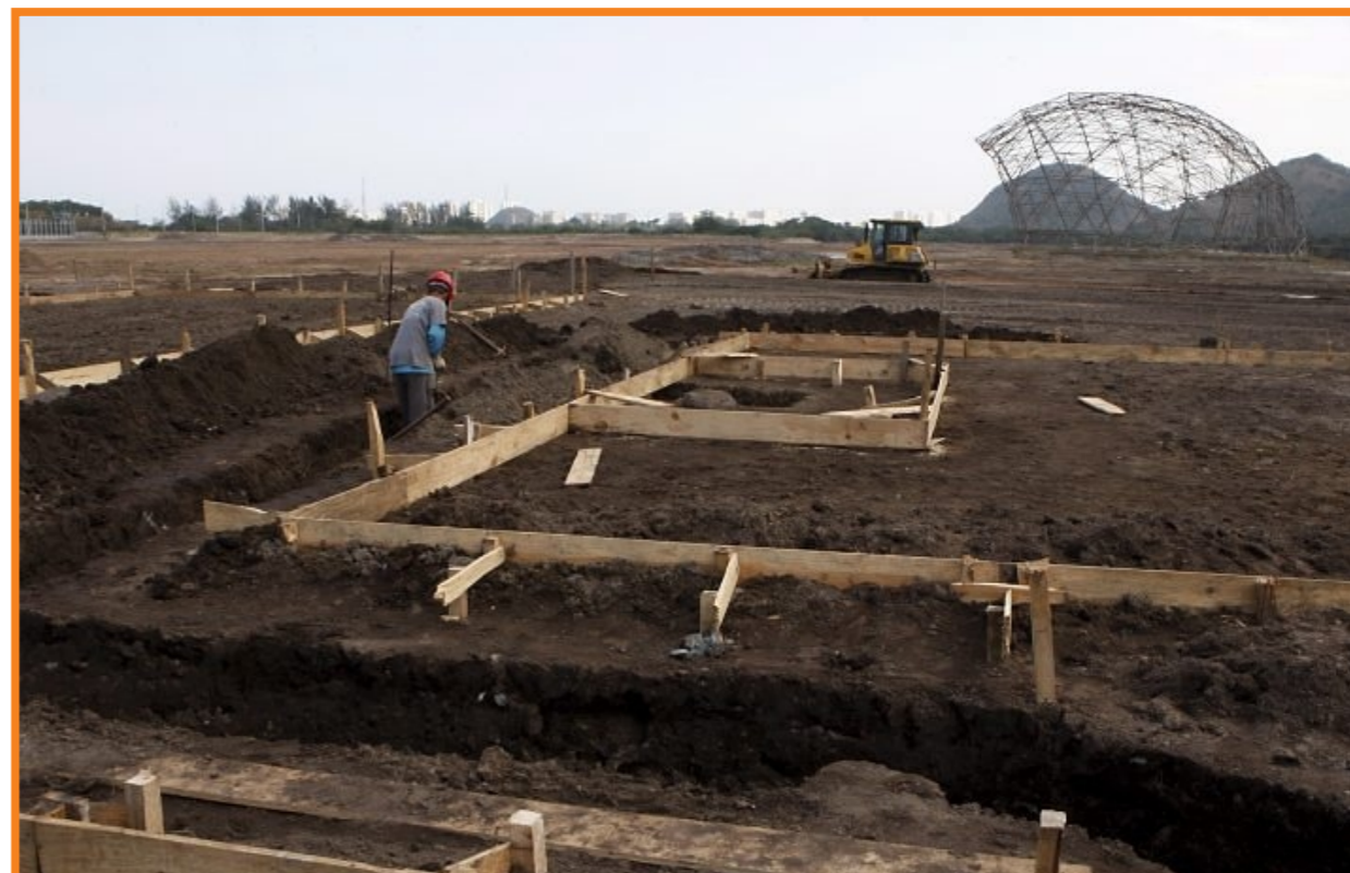
Canteiro de Obras - Vila Olímpica
