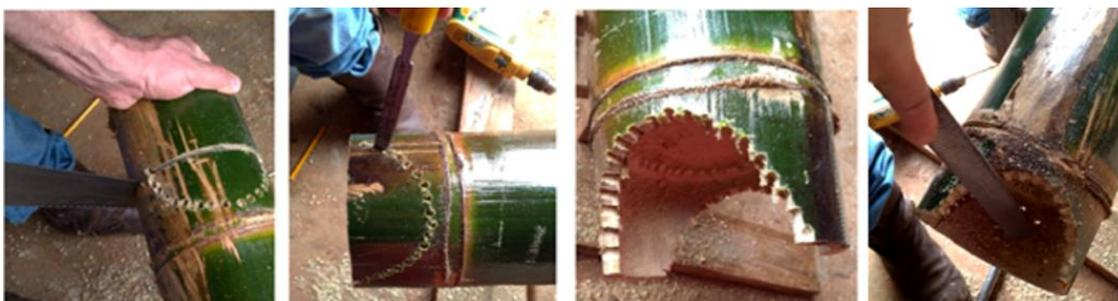
**Figura 13: Furação e corte do encaixe tipo boca de peixe na ponta de uma peça de bambu gigante.**
