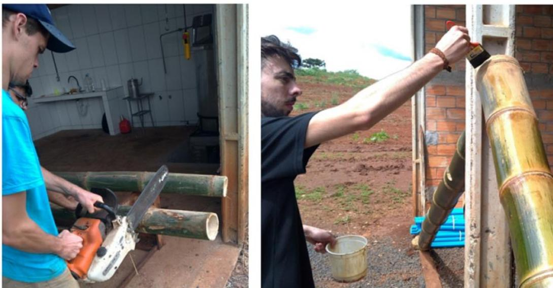
**Figura 9: Corte de peças de bambu gigante usando motosserra e aplicação de preservante com pincel.**
