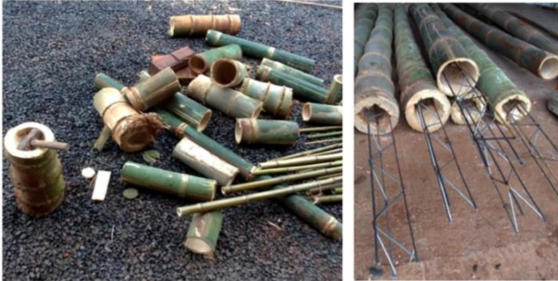
**Figura 8: Ponteiras dos colmos destopados e peças com treliça metálica para ser usada como colunas.**
