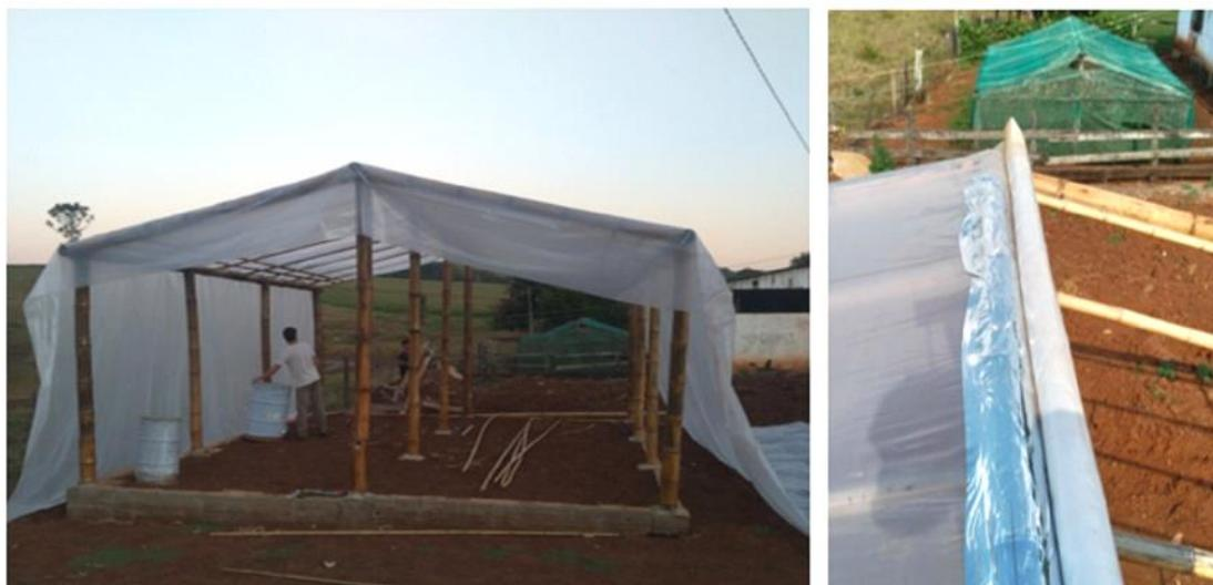
**Figura 24: Colocação do filme plástico na cobertura e nas paredes laterais da estufa e detalhe do filme enrolado sobre a estrutura do telhado.**
