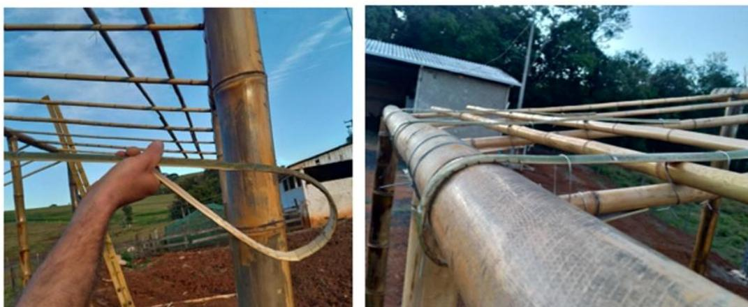
**Figura 23: Ripa de bambu cana da índia, dobrada no calor, usada para melhorar a saída de água da chuva. Detalhe de amarração destas ripas em volta da viga lateral.**
