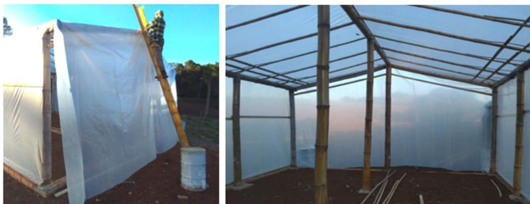
**Figura 27: Trabalhador no alto da escada para fixar o filme plástico de uma parede e vista interna da estufa fechada.**
