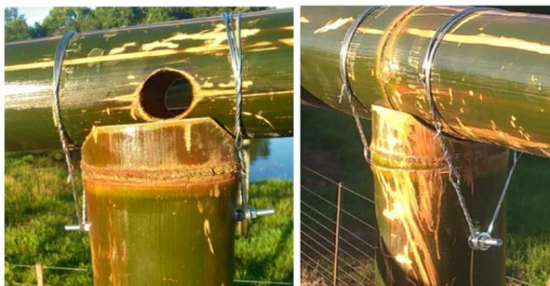
**Figura 17: Detalhe da boca de peixe e da amarração das peças usando barra roscada e arame de aço.**
