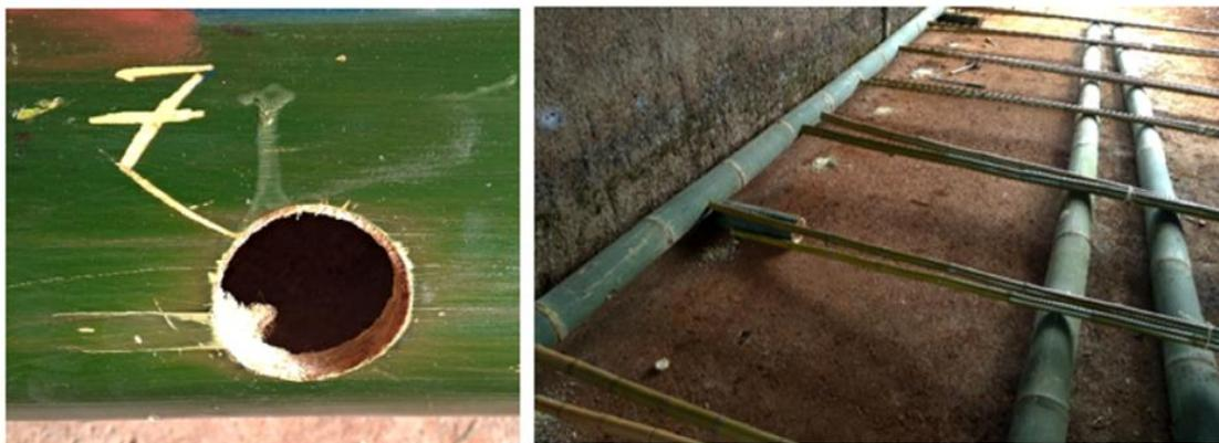
**Figura 12: Marcação do furo 7 e pares de peças de cana da Índia para serem ajustadas na viga mestra.**
