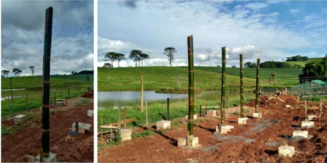
**Figura 14: Colocação das primeiras colunas, fundação em concreto com esperas de treliças de aço.**
