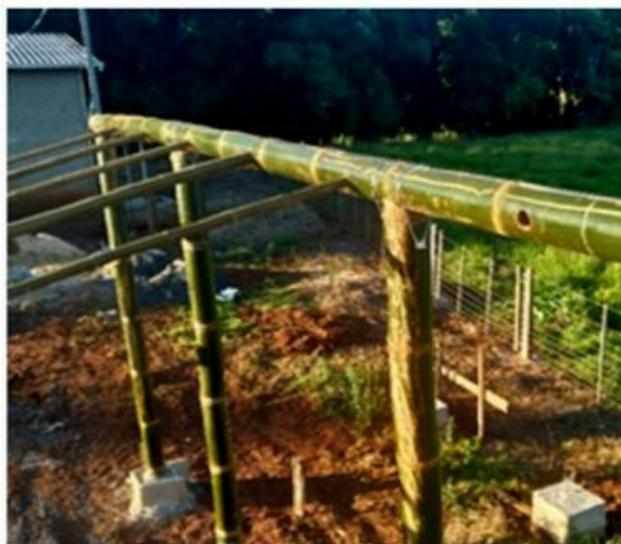
**Figura 19: Encaixe das varas de cana da Índia nos furos da viga mestra.**
