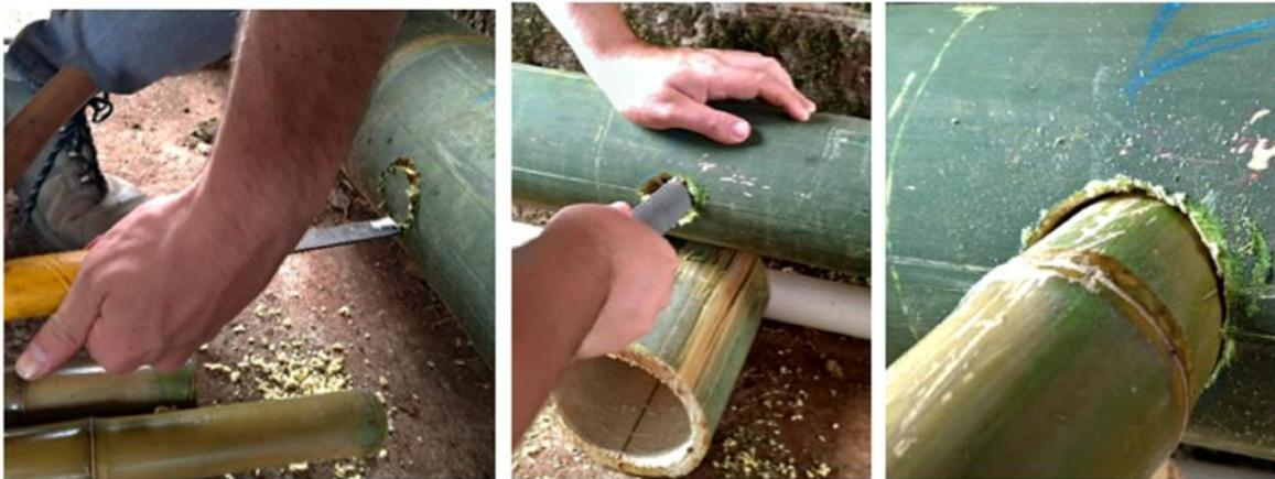
**Figura 11: Usando formão e grosa para terminar e ajustar o furo e encaixe realizado.**
