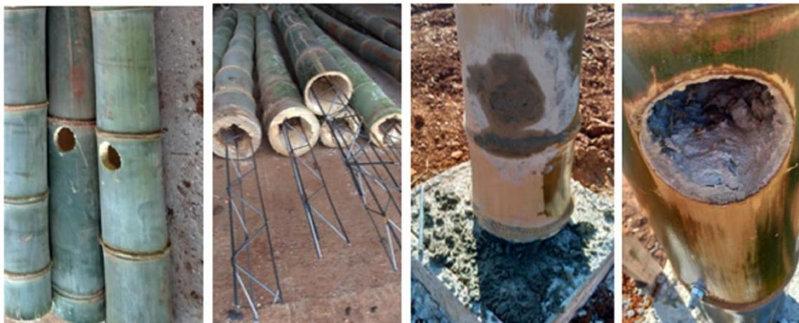
**Figura 18: Colunas de bambu, detalhes dos furos para introdução do concreto, das treliças metálicas usadas, no momento de sua concretagem nas sapatas e com o concreto já curado.**
