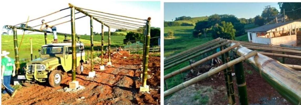
**Figura 21: Estrutura da estufa antes de concretar as colunas laterais, usando o jipe como andaime.**
