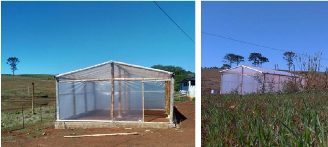
**Figura 28: Vista frontal e traseira da estufa de bambu quase finalizada.**
