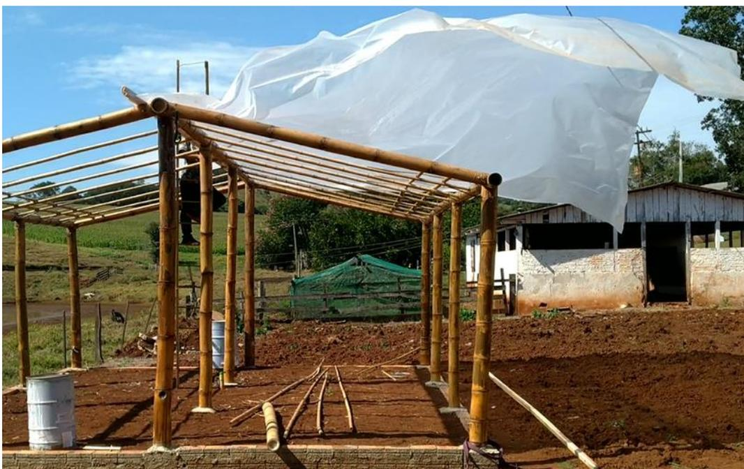
**Figura 25: Ação de vento leve sobre o filme plástico ainda solto sobre a cobertura da estufa de bambu.**
