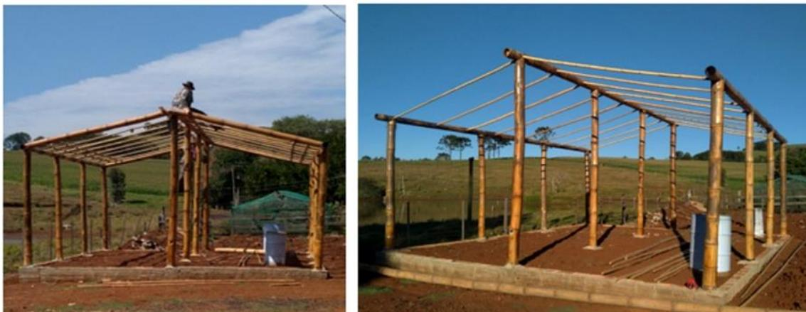
**Figura 22: Trabalhador sobre a estrutura, detalhe da cinta de tijolos no chão.**
