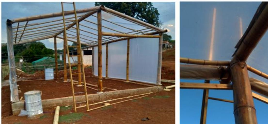
**Figura 26: Filme plástico já esticado e fixado sobre o telhado e nas paredes laterais da estufa.**
