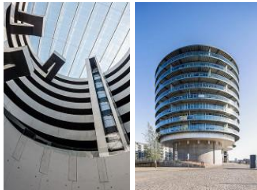
A esquerda uma vista ao topo do interior dos silos e a direita uma imagem da lateral externa do edifício que mostra a descaracterização da escala original do objeto industrial. FONTE: http://flickrhivemind.net
