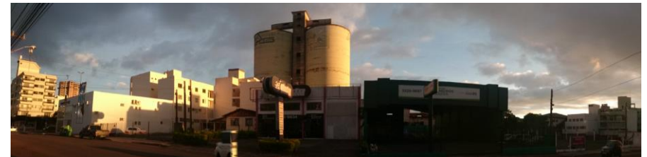
Panorâmica da fachada na rua Paulo Marquês. FONTE: acervo pessoal
