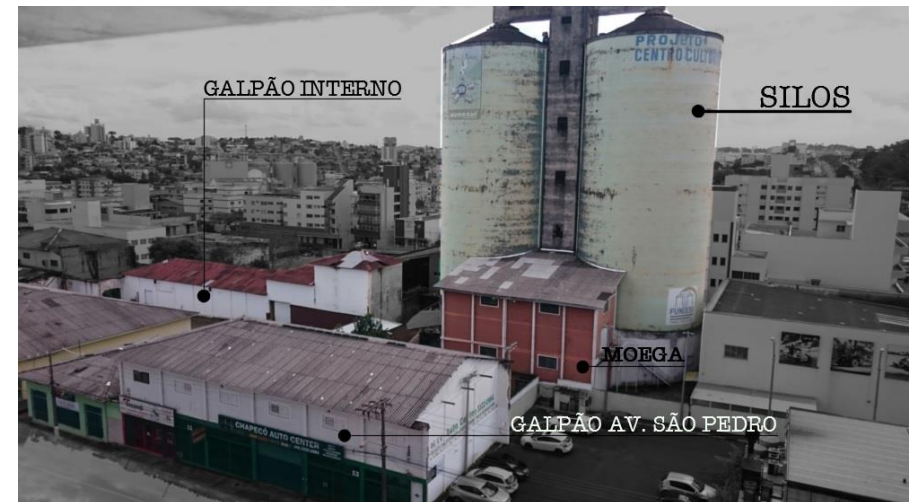
Conformação atual das preexistências industriais (silos, moega em anexo, galpão interno (reboco branco) e galpões próximos à avenida São Pedro (tijolos pintados, uso comercial e institucional). FONTE: acervo pessoal.
