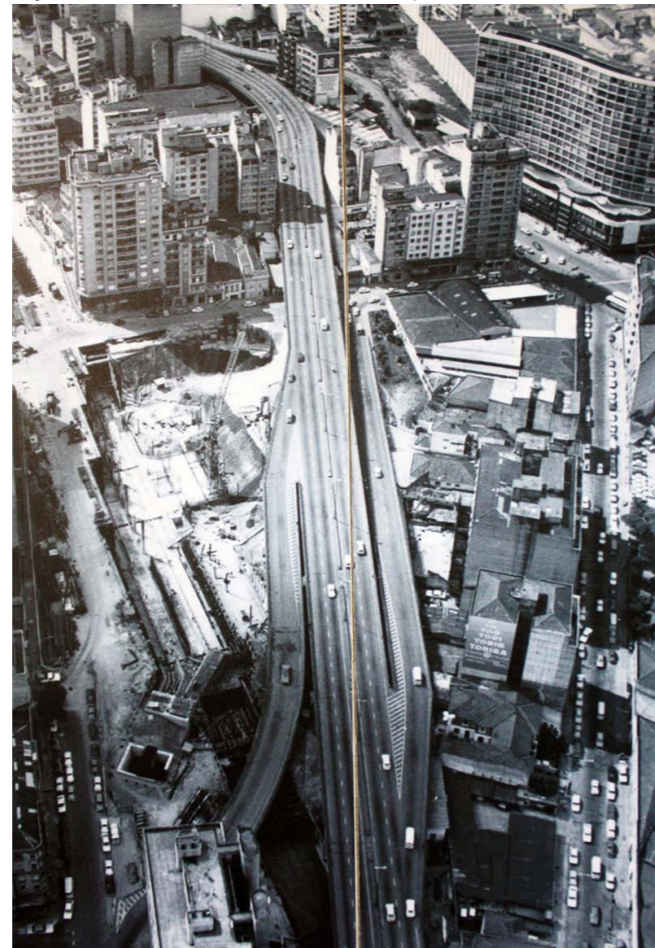
Imagem 44. Obras do metrô Santa Cecília nos anos 80. Fonte: Arquivo do Metrô.
