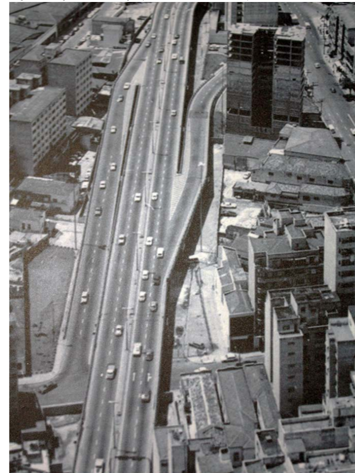
Imagem 45. Situação antes das demolições para as obras do metrô. Fonte: Arquivo do Metrô.
