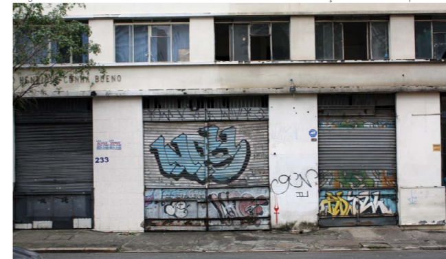
Imagem 40. Edifícios no entorno da área de intervenção. Fonte: Acervo pessoal.
