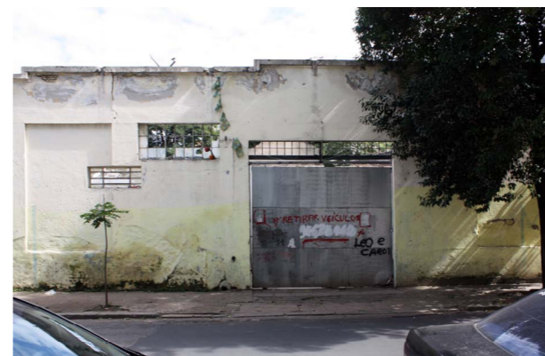
Imagem 35. Edifício abandonado na área de intervenção em Maio. Fonte: Acervo pessoal.
