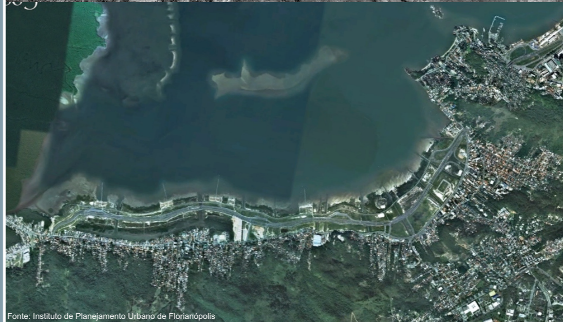
Aterro da Via-expressa Sul 1938 e 2010, respectivamente.
