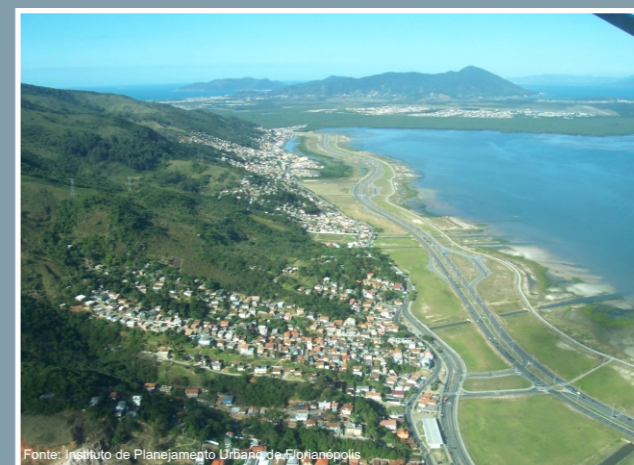
Ocupação nas encostas do Saco dos Limões
