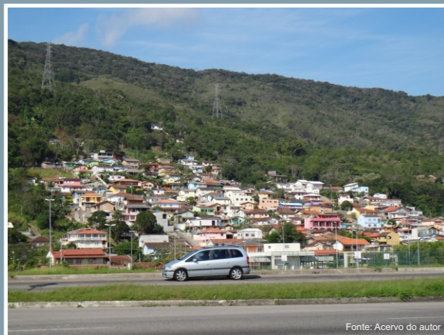
Ocupação irregular nas encostas da Costeira
