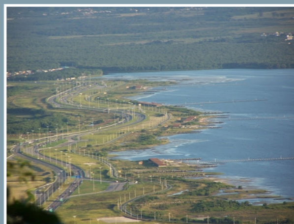
As obras do aterro não foram totalmente finalizadas
