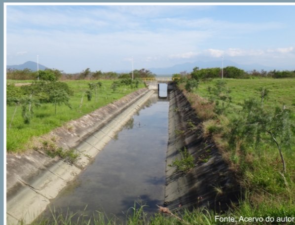
Canais provisórios de drenagem do aterro
