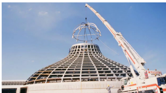
Figura 28 – Auditório em construção. Fonte: Museu da Casa Brasileira (vídeo no Youtube).
