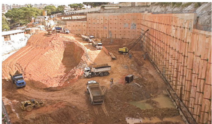
Figura 47– Parede-diafragma aplicada para contenção do terreno. Fonte:
