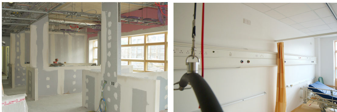
Figura 101 – Vedações em Drywall no Hospital Whiston, Inglaterra. Fonte: http://www.knaufdrywall.co.uk
