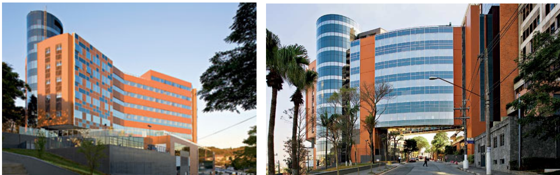
Figura 37 e 38, respectivamente – Fachada adjacente a praça externa e o edifício-passarela.
