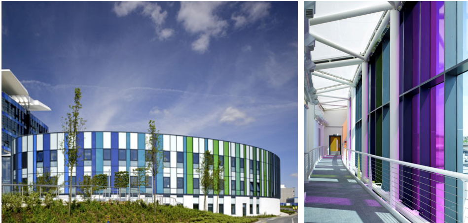
Figura 95 – Fachada proporcionando iluminação e ventilação natural do King’s Mill Hospital em Mansfield, Reino Unido. Fonte: http://www.arnewde.com
