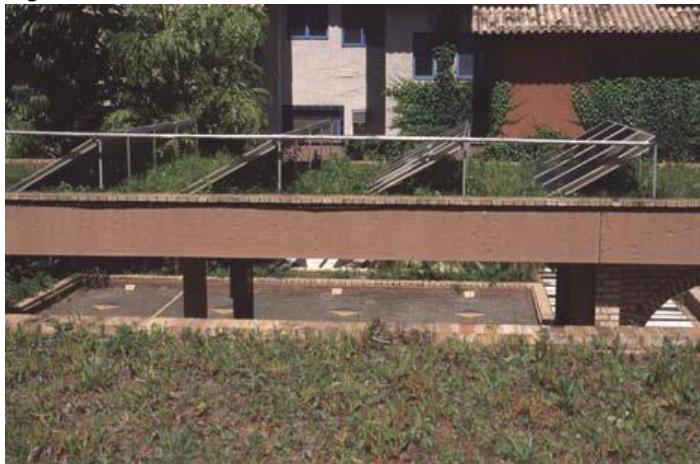
Figura 5: Telhado verde extensivo sobre uma área de estacionamento.
