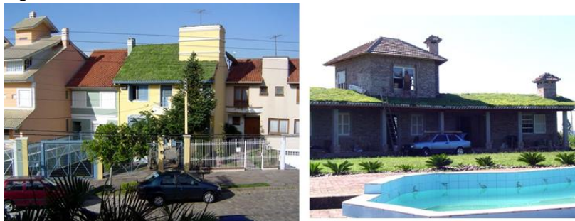
Figura 4: Telhados verdes em residências com telhados inclinados
