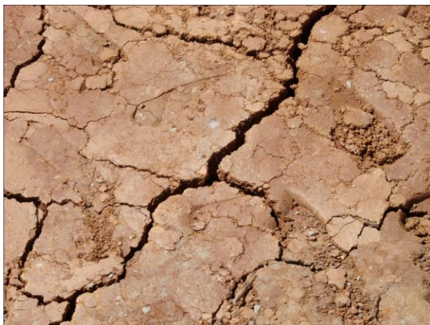
Figura 1.5 – Rachaduras de ressecamento causadas pelos ciclos de hidratação e secagem em um solo argiloso de uma bacia de contenção
