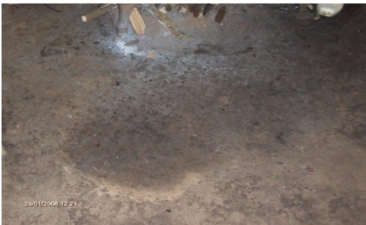
Local onde ficava o borrarho, espécie de fogo de chão. Este local fica na cozinha da família Nunes e tem mais de 150 anos.(SILVA, et al, 2008)
