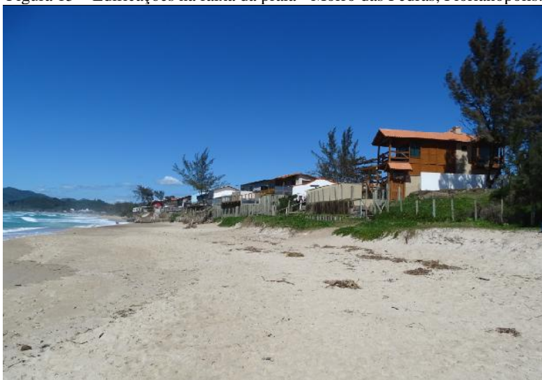
Figura 15 – Edificações na faixa da praia - Morro das Pedras, Florianópolis.
