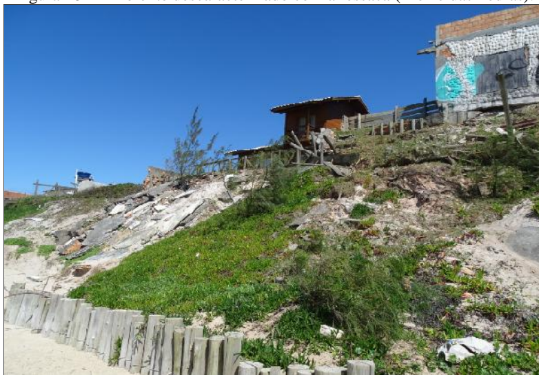
Figura 18 – Ambiente descaracterizado com a ressaca (Morro das Pedras).
