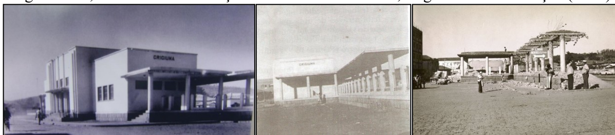
Figuras 155; 156- Moderna Estação Criciúma Concl. 1950; Figura 157- Demolição (1975)
