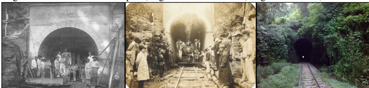
Figura 95- Obras Túnel/Siderópolis; Figura 96- final de obra; Figura 97- Túnel, atualmente
