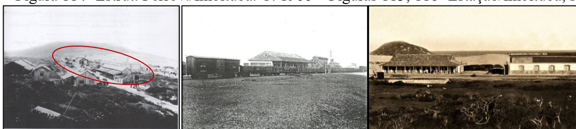
Figura 114- Estrut. Ferrov./Imbituba. C. 1900 Figuras 115; 116- Estação/Imbituba, s/d
