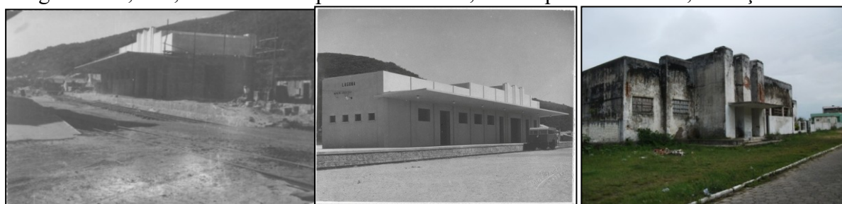
Figuras 152; 153; 154- Est. Campo Fora. C. 1943; Plataf. pronta. C. 1943; Situação atual
