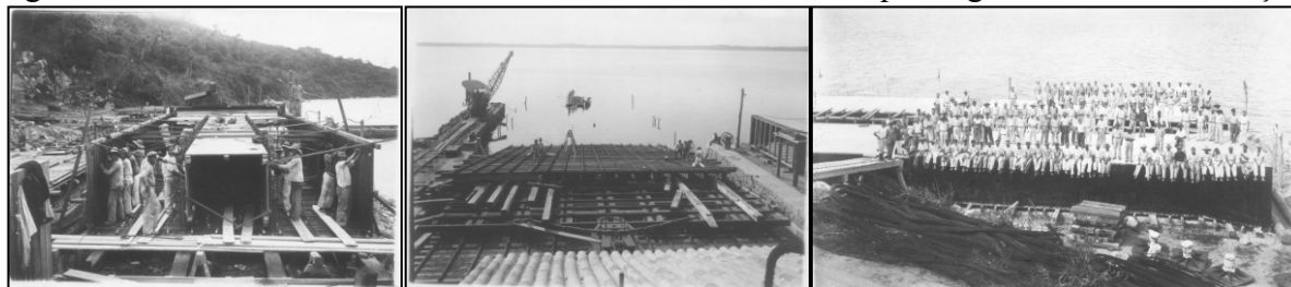
Figuras 98; 99; 100- Trabalhadores da Ponte Ferroviária Henrique Lage, início de Construção
