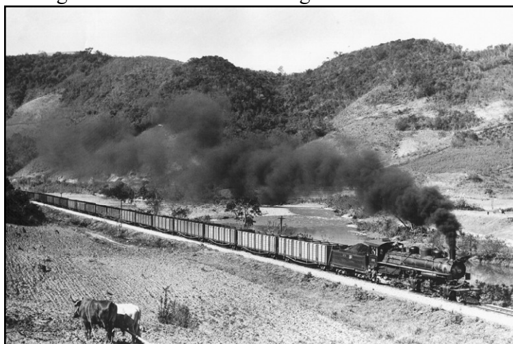
Figura 88- A Ferrovia na Margem do Rio Tubarão
