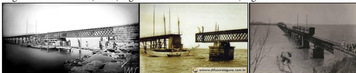
Figura 101- Conclusão, 1884; Figura 102- Vão móv. C. 1900; Figura 103- Comboio C.1920
