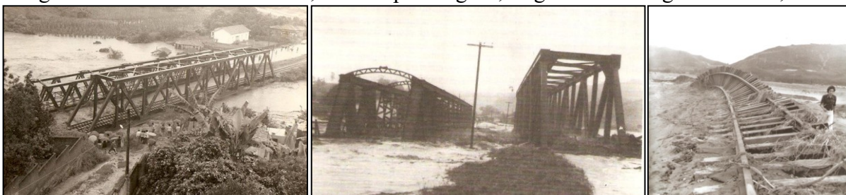
Figuras 90 e 91- Pontes/Orleans, tomada pelas águas; Figura 92- Estragos enchente, 1974
