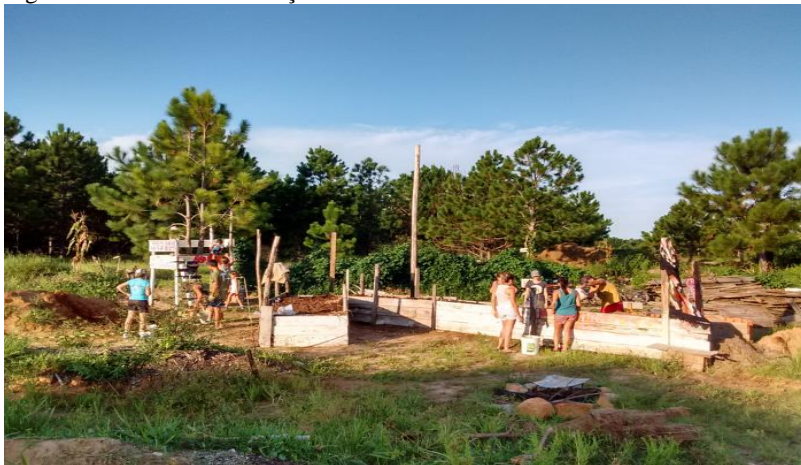
Figura 45: Início da construção do maior canteiro da horta em formato de avião.
