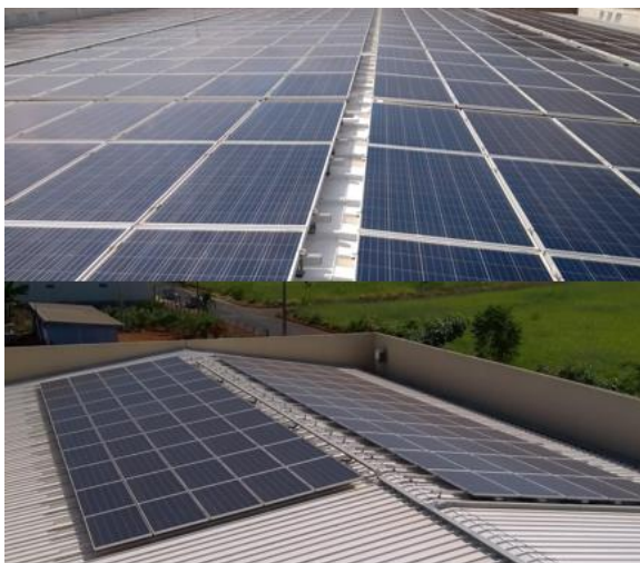
Figura 2: Placas fotovoltaicas instaladas no campus 1 e 2 respectivamente Fonte: UFCAT, 2019.
