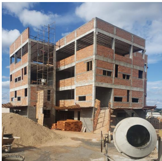
Figura 3: Obra da Casa do Estudante da UFCAT. Fonte: Elaborado pelos autores, 2020.
