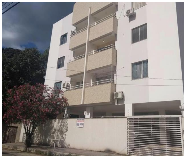
Figura 1: Fachada principal do edifício. Fonte: elaborado pelos autores.
