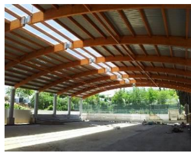
Figura 24 – Estrutura de cobertura em arco feita com madeira. Fonte: Carmo Wood.
