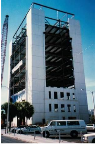
Figura 6 – Edifício com painéis de vedação em concreto, Flórida. Fonte: PCI, 2007, p.92.
