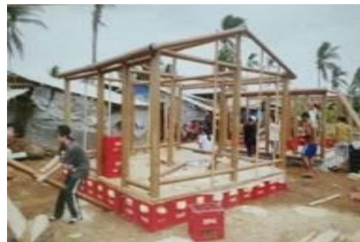
Figura 20 – Construção do abrigo. Fonte: Jodidio, 2015, p.532.
