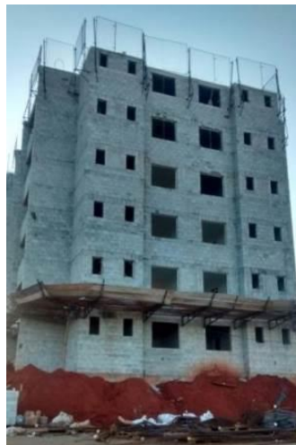
Figura 9 – Construção do empreendimento Flora Park II. Fonte: Peluso et al., 2015, p.35.
