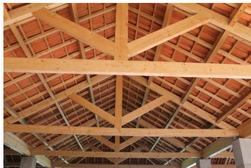
Figura 16 – Estrutura em madeira para cobertura. Fonte: Carmo Wood.
