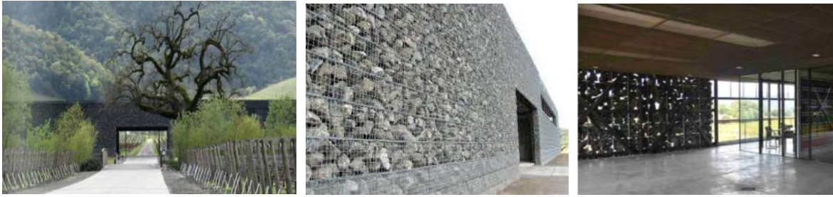
Figura 5, 6 e 7: Fachada da Adegas Dominus / Gambiões de pedras locais / fechamentos de pedra internamente “translúcidos” da Adegas Dominus. Fonte: HERZOG & MEURON, 1998. p. 16-34.
