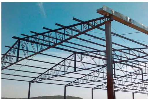
Figura 15 – Estrutura metálica treliçada para cobertura. Fonte: MA Steel.
