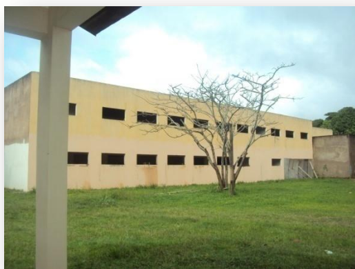
Figura 29 – Visão externa da biblioteca e prédio de administração acadêmica
