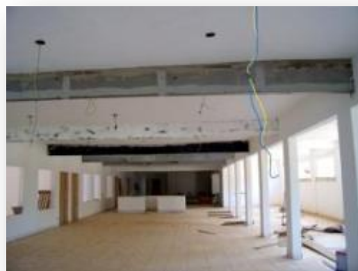
Figura 30 – Visão interna da biblioteca e prédio de administração acadêmica
