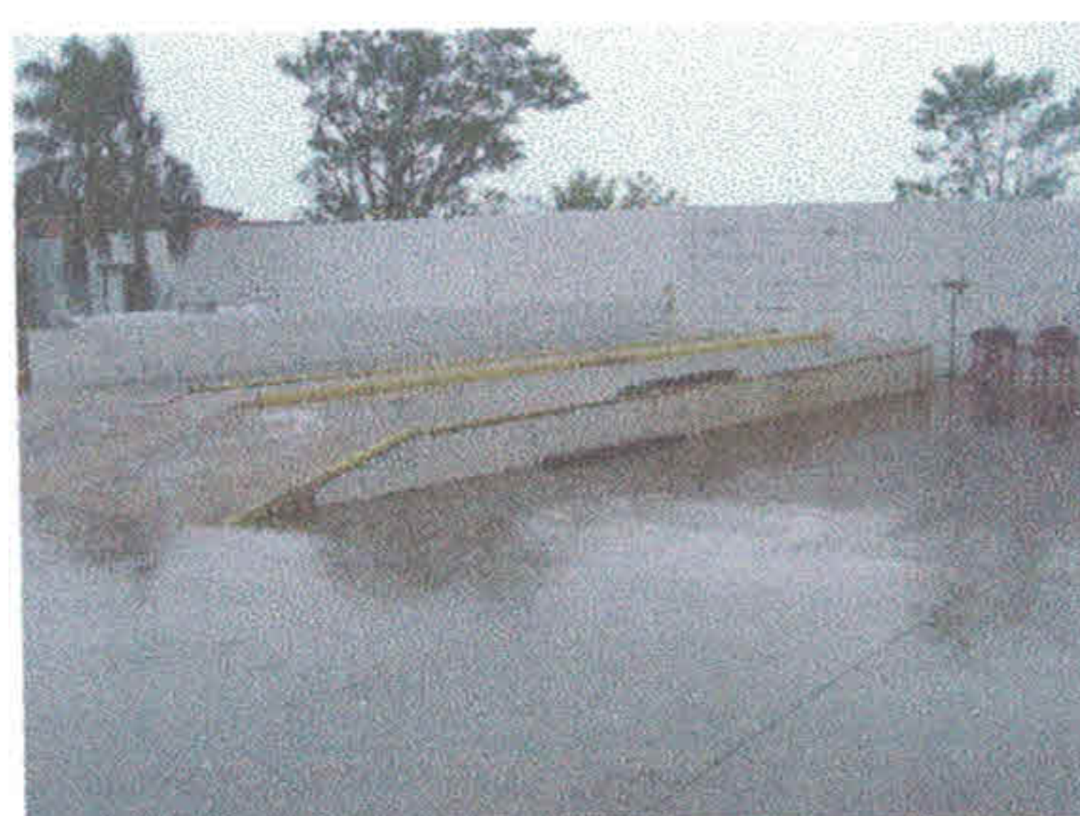
Rampa de lavação
