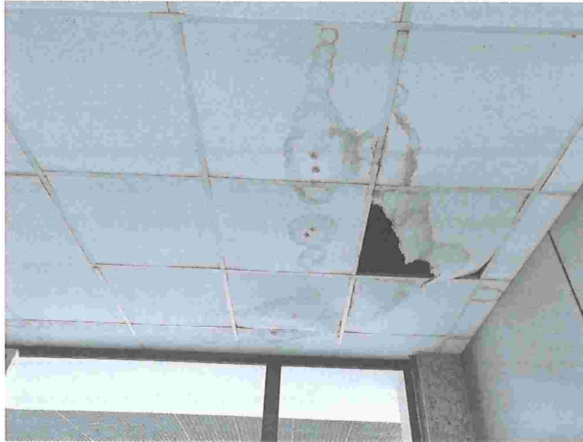
Figura 2 - Detalhe do forro do primeiro pavimento
