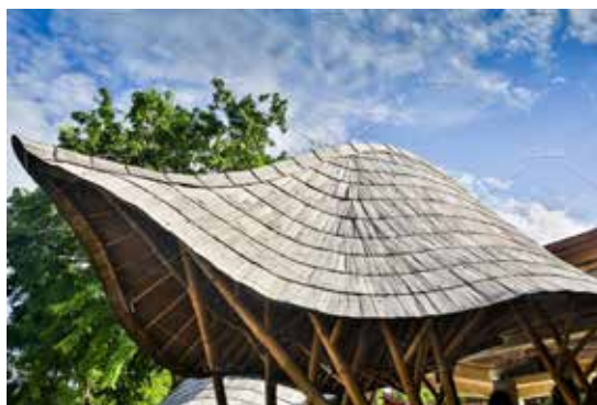
Estrutura em bambu Gigantochloa apus
