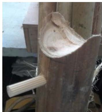
c) Inserção de cilindros de madeira nas extremidades dos pilares e vigas, corte boca de peixe nos pilares e ancoragem com pino de madeira
