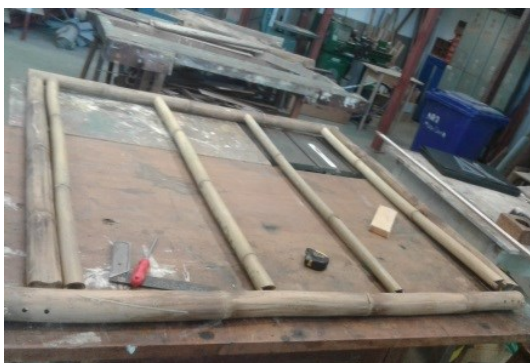
Figura 45 - Detalhes na montagem dos painéis de vedação.
