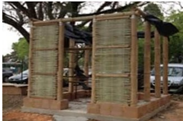
f) Painel grande e disposição final na estrutura. FAU/USP
