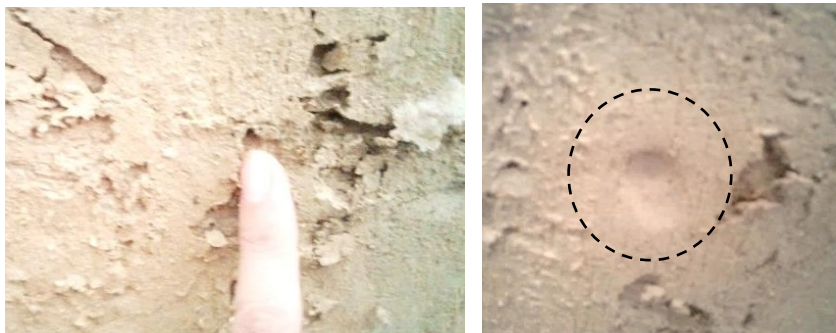
Figura 49 - Erosão do reboco no CPA após ensaio de estanqueidade e baixo relevo causado pela pressão do dedo em outro local do painel.
