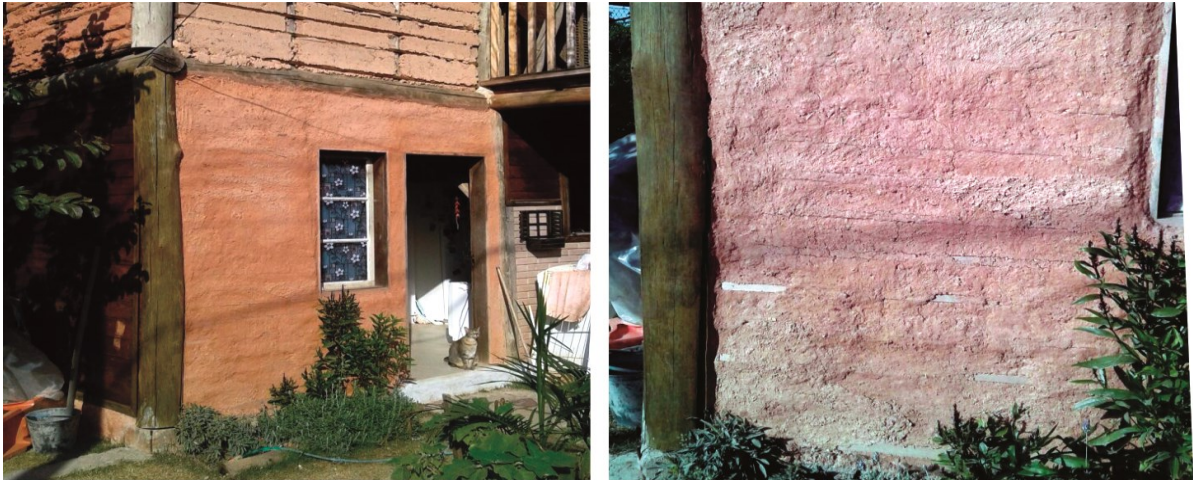
Figura 27 - Vista da parede nordeste e detalhe das fissuras e descolamento da argamassa.
