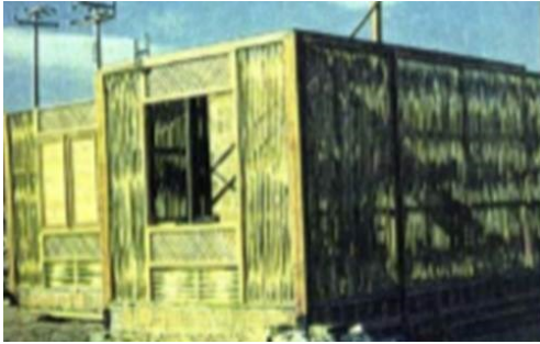
Figura 19 - Painéis técnica mista com trama de bambu e madeira, no Brasil.
