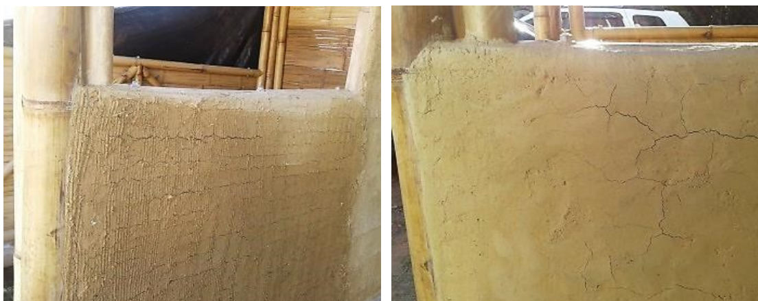
Figura 42 - (da direita para esquerda) Fissuras no emboço e no reboco sobre na fachada leste.
