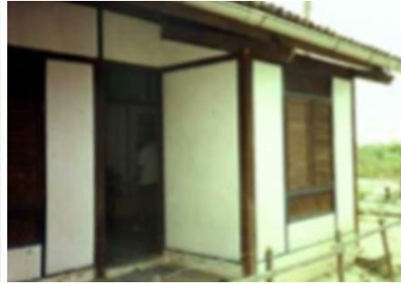
Figura 19 - Painéis técnica mista com trama de bambu e madeira, no Brasil.
