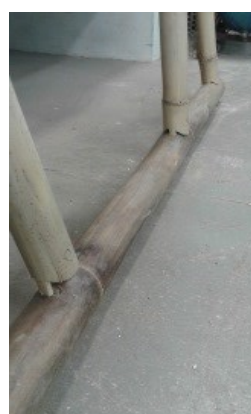
d) Corte duas orelhas nas peças secundárias e furos nas vigas
