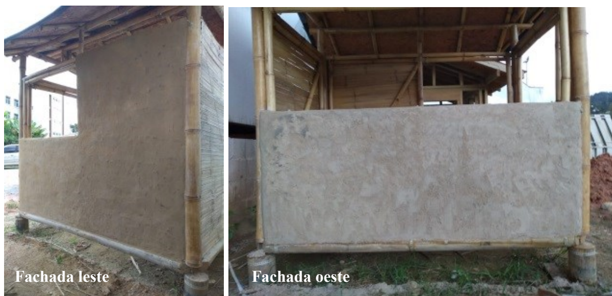
Figura 41 - Teste de argamassa de reboco a base de cal sobre emboço ora com cimento ora com cal.
