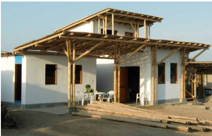
Figura 30 - Residência unifamiliar com painéis de pau a pique num sistema construtivo em bambu segundo a Norma de Bambu Peruana E.100.
