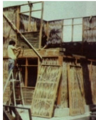
Figura 20 - Painéis técnica mista com trama de bambu, na América Latina.
