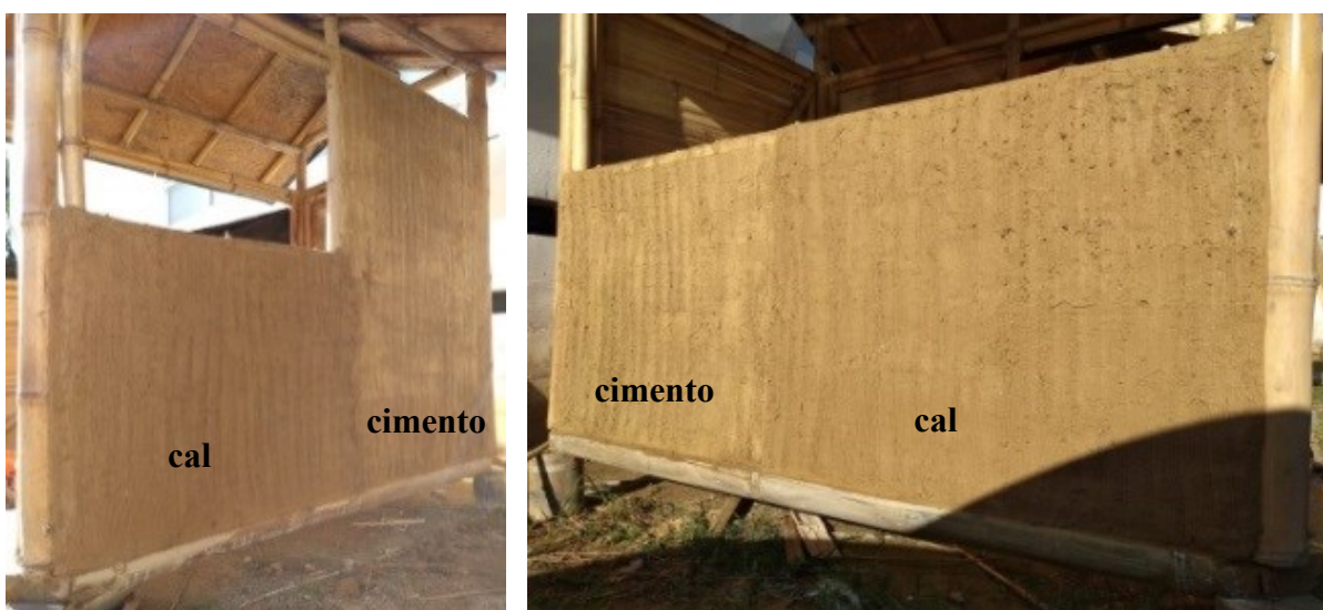
Figura 40 - (da esquerda para direita) Testes de diferentes traços de emboço sobre quincha fachada leste e oeste.
