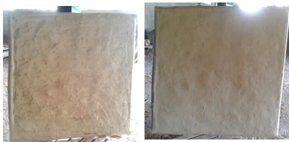
d) Painel B, aplicação do emboço e do reboco em uma das faces
