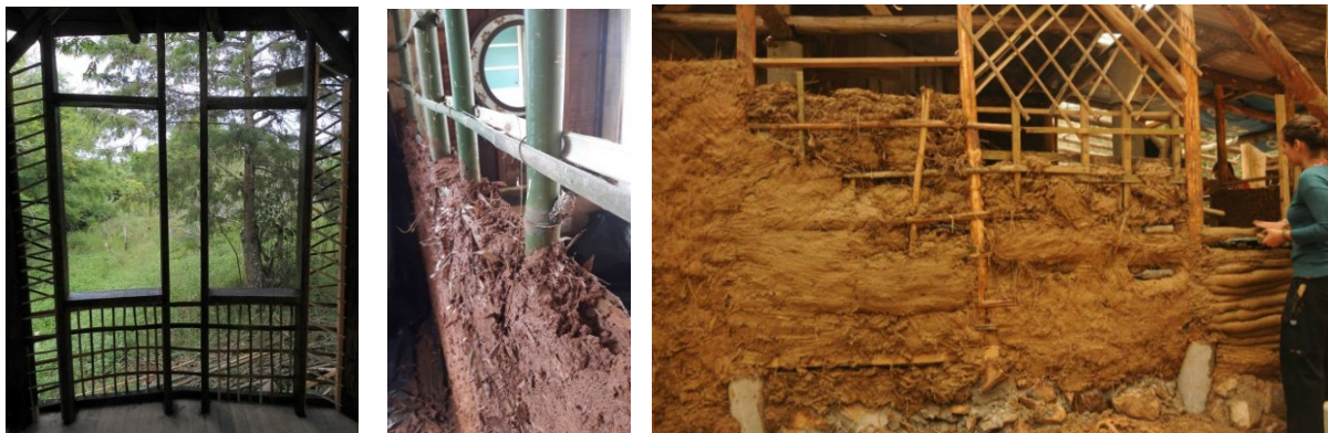
Figura 24 - (da esquerda para direita) Imagens das tramas diversas: ortogonal com trama simples, trama dupla e trama variada.
