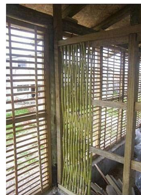
c) Detalhes dos painéis externos e internos habitação Cooperativa Vaimaca/Uruguai
