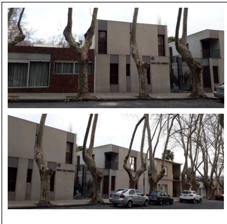
Fig. 90: Patio del Bastión Fachada.
