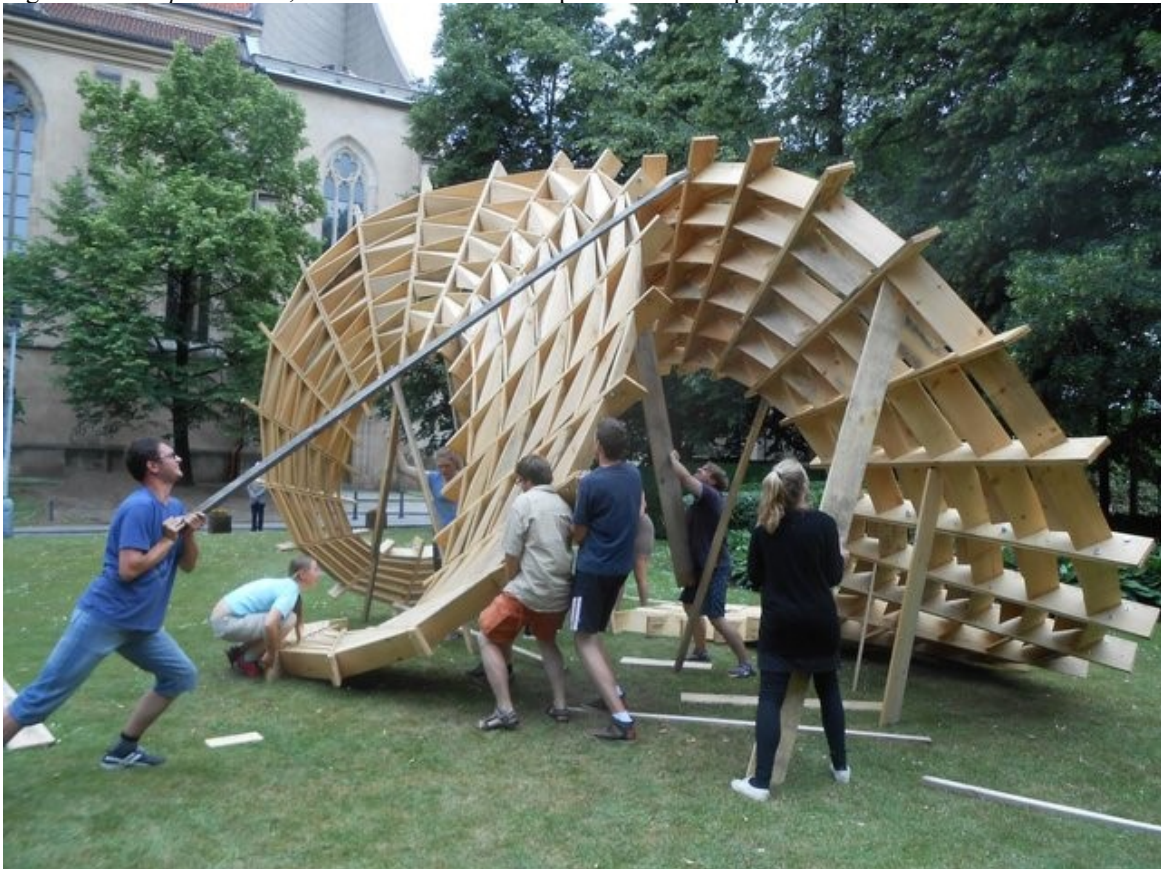
Figura 18 - Loop Pavillion , estrutura em escala real produzida na República Tcheca
