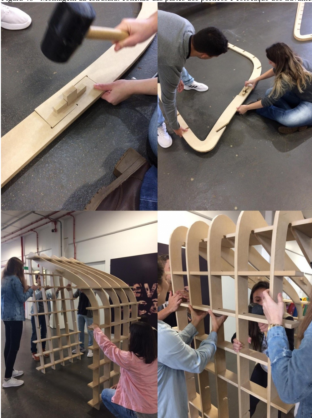
Figura 48 - Montagem da estrutura: conexão das partes dos pórticos e colocação dos travamentos.
