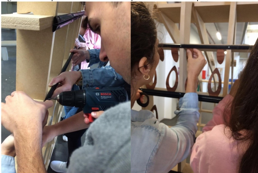
Figura 49 - Fixação das canaletas e colocação dos elementos responsivos.
