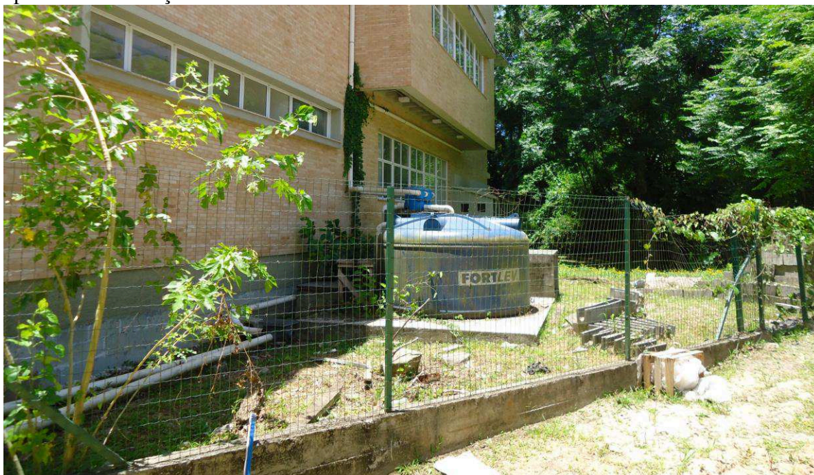
Fotografia 9 - A utilização de sistemas tecnológicos de captação de energia e água não apresentam resoluções estéticas
