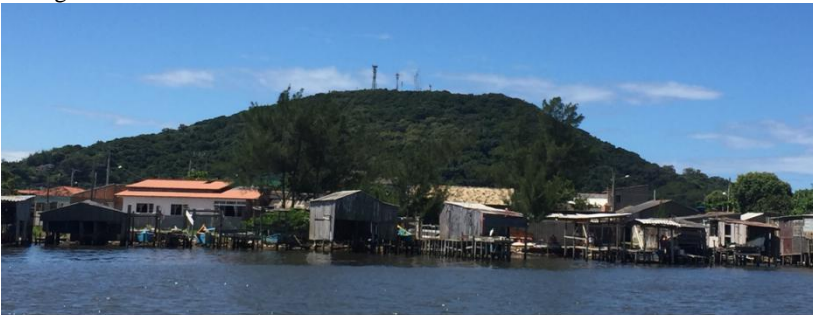
Figura 51 - Trecho II - Vila Vitória, sarilhos maiores e ranchos de pesca à beira da Lagoa.
