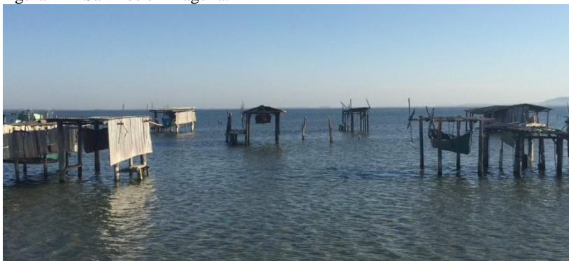
Figura 41 - Sarilhos em Laguna.
