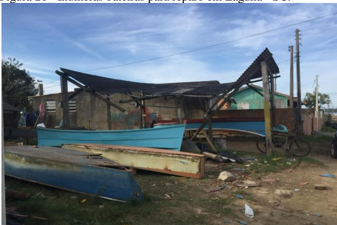
Figura 26 - Inúmeras bateiras para reparo em Laguna - SC.
