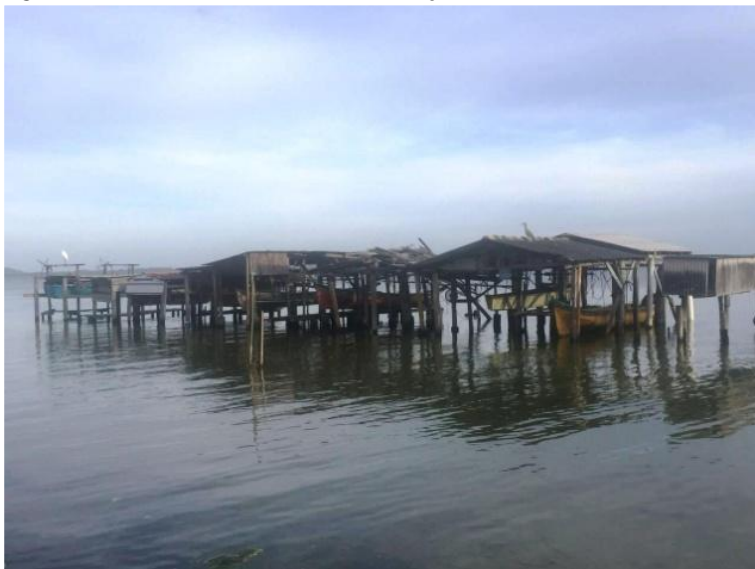
Figura 59 - Sarilhos no Trecho VII - Cabeçadas.
