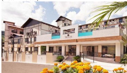
Figura 95: Inserção arquitetônica contemporânea em hotel com características da arquitetura neoenxaimel (Hotel Tirolesa).
