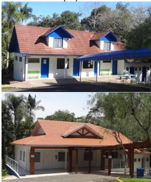
Figura 99: Edifício da clínica de exames médicos da Companhia Hidromineral de Piratuba, antes e após obra de reforma e ampliação realizada em 2016.
