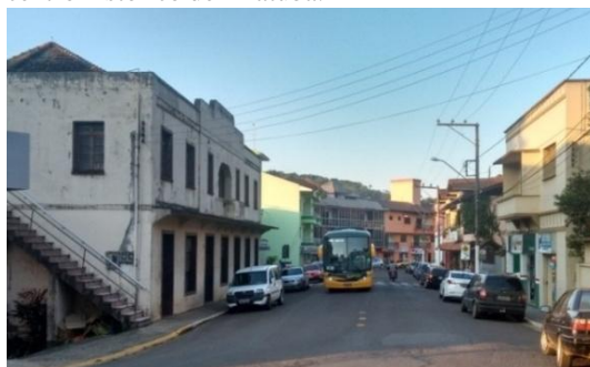
Figura 81: Vista da Avenida 18 de Fevereiro, no centro histórico de Piratuba.
