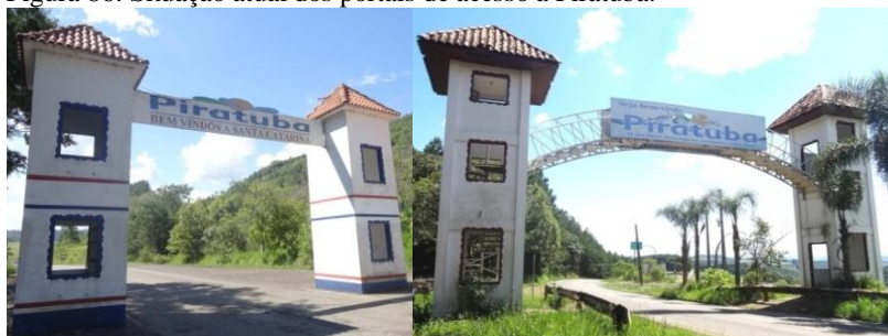
Figura 86: Situação atual dos portais de acesso a Piratuba.
