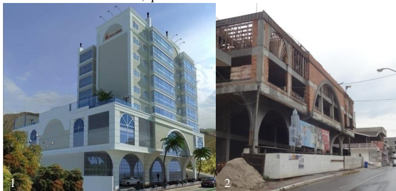
Figura 98: Empreendimento imobiliário em execução na porção intermediária da Avenida 18 de Fevereiro, que referencia elementos da estética neoclássica.
