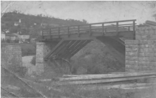
Figura 38: Construção da ponte sobre o Rio do Peixe, com o núcleo urbano de Piratuba ao fundo, 1950 55 .
