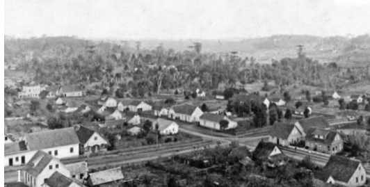
Figura 22: Arquitetura em madeira construída no território catarinense cruzado pela antiga Estrada de Ferro São Paulo-Rio Grande no início do século XX.
