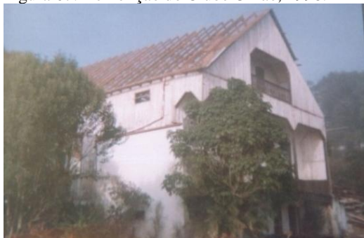
Figura 67: Demolição do Clube União, 1998.
