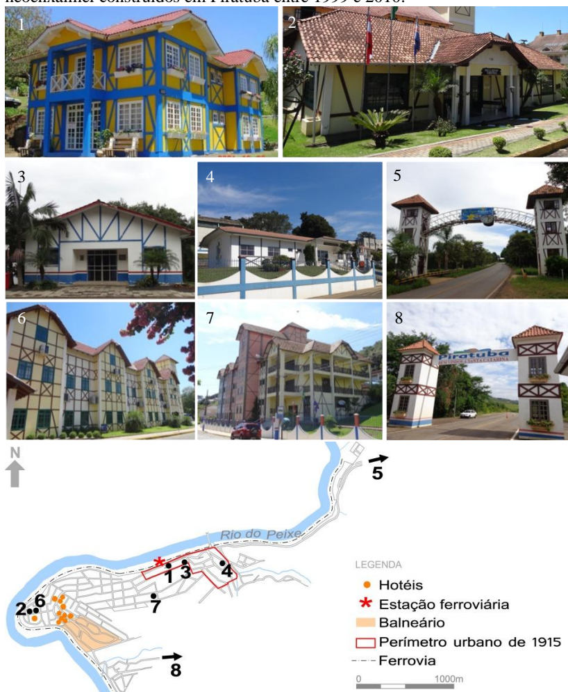
Figura 60: Edifícios públicos seguindo características da arquitetura neoenxaimel construídos em Piratuba entre 1999 e 2010.
