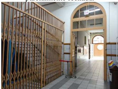
Figura 73 - Porta pantográfica da Escada 4, junto ao térreo, parcialmente fechada.
