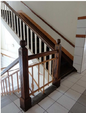
Figura 75 - Guarda-corpo da Escada 2.
