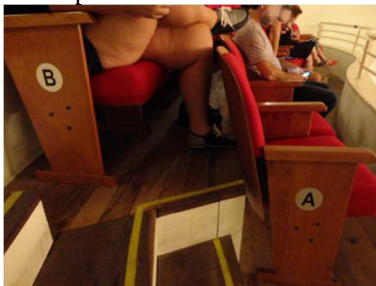
Figura 53 - Detalhe do espaço entre as poltronas do nível balcão.
