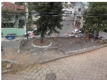
Figura 24 - Condições atuais da Praça Antonio Carlos Ferreira
