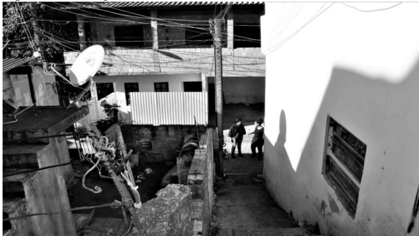
Figura 32 - Exemplo de obra de acessibilidade na comunidade
