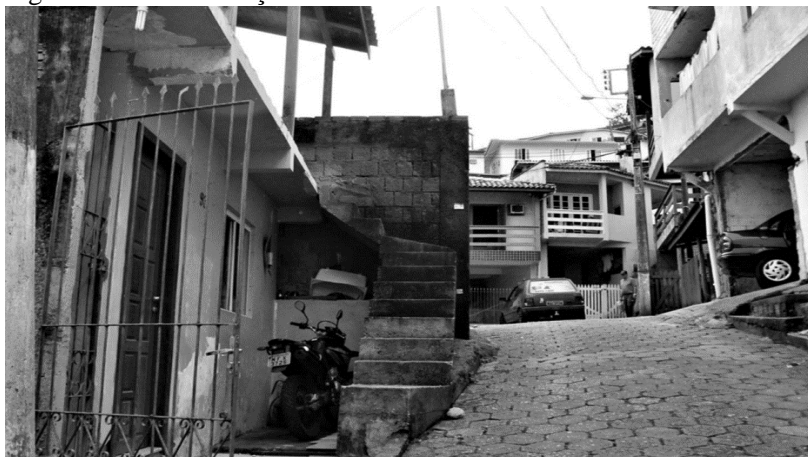
Figura 35 - Pavimentação de via - setor G
