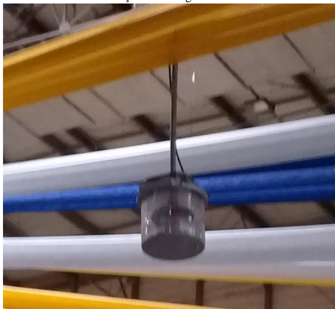
Figura 29 - Sistema de informação de emergência
