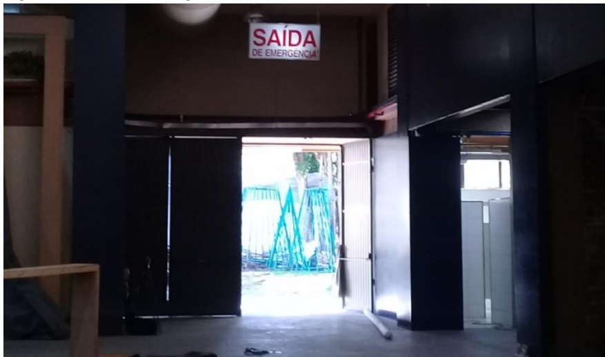
Figura 18 - Saída de emergência localizada no setor 2
