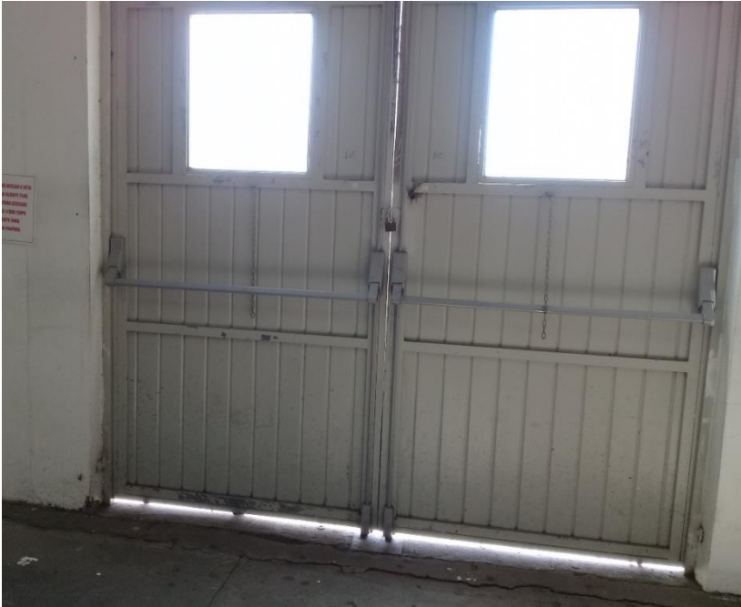
Figura 25 - Portas anti-pânico no setor 3 em direção à Rua Humberto de Campos
