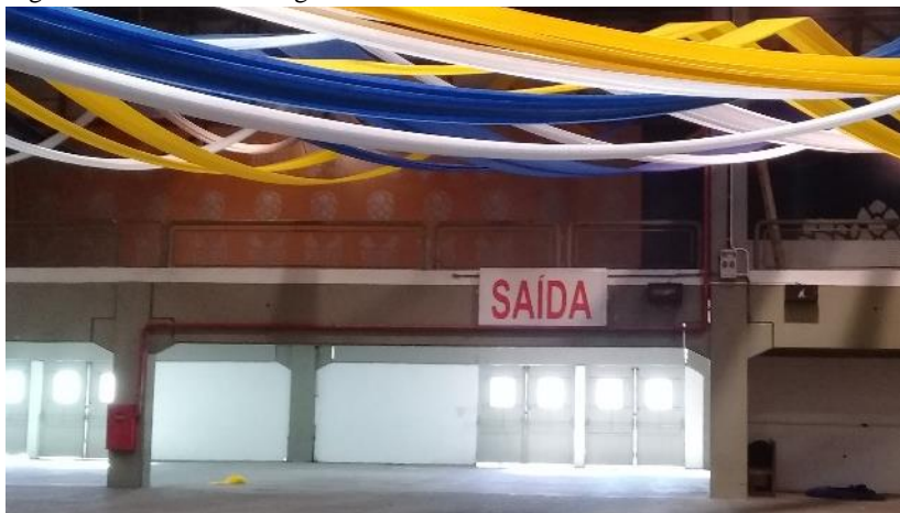
Figura 21 - Saída de emergência setor 3
