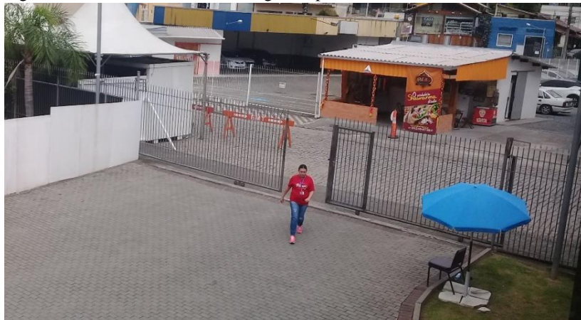
Figura 24 – Portão de saída de emergência para a Rua Herbert Welmuth
