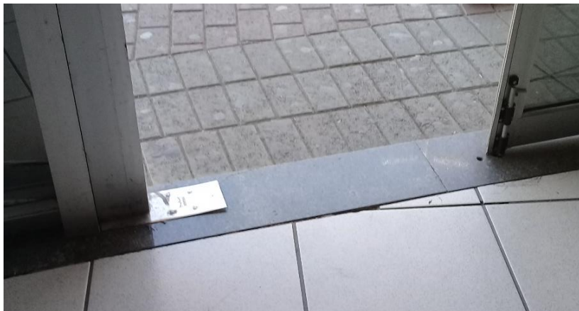
Figura 20 - Mudança de piso entre área interna do setor 1 e área externa do parque
