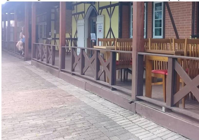
Figura 23 - Degrau isolado entre deck restaurante e área externa do parque
